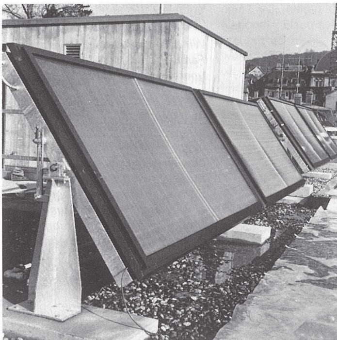
Die Sonnenkollektoren auf dem Dach unseres Bürohauses heizen einen Wasserkreislauf, der über einen Wärmeaustauscher das Brauchwasser für Kantine, Waschbecken und Sauna erwärmt. Die Anlage wird im «Schiblianer», wenn mehr Erfahrungs- und Messwerte vorliegen, im Detail vorgestellt. Fabrikat der Kollektoren: Star Unity, Au-Zürich. Konsolen mit Schwenkbereich für Sonnenstand von 30-75°: Fabrikat SCHIBLI-Maschinenbau, Schwerzenbach.
