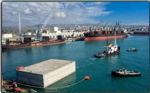
Il Rimorchiatore della Fincosit manovra per consegnare il cassone al Rimorchiatore di altura.
