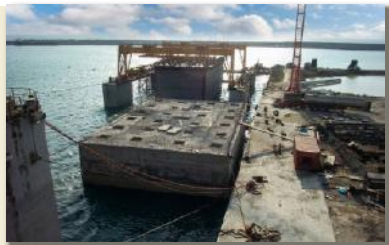
Alcune fasi nella costruzione dei Cassoni (Fincosit)
