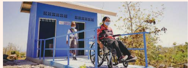
📷 Pembangunan fasilitas toilet dan sanitasi yang layak, berkesetaraan gender, dan inklusif di Nusa Tenggara Barat dan Nusa Tenggara Timur. Toilet ini dilengkapi dengan handrail , kloset duduk, fasilitas cuci tangan pakai sabun (CTPS) dengan ketinggian tertentu, dan fasilitas Manajemen Kebersihan Menstruasi (MKM).
