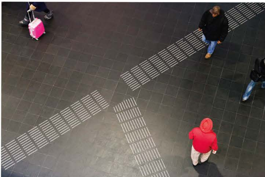
Geleidelijnen in een stationshal.
