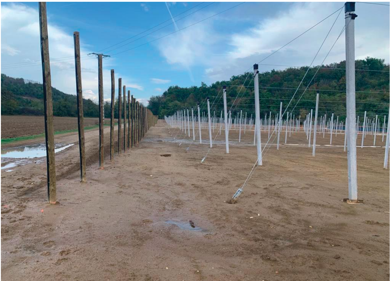
Mise en place d'une implantation
