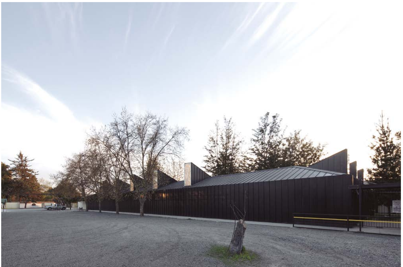
Colegio Alianza Francesa Curicó - Arquitectos: Guillermo Hevia García + Nicolás Urzúa - Producto: CD455 SL
