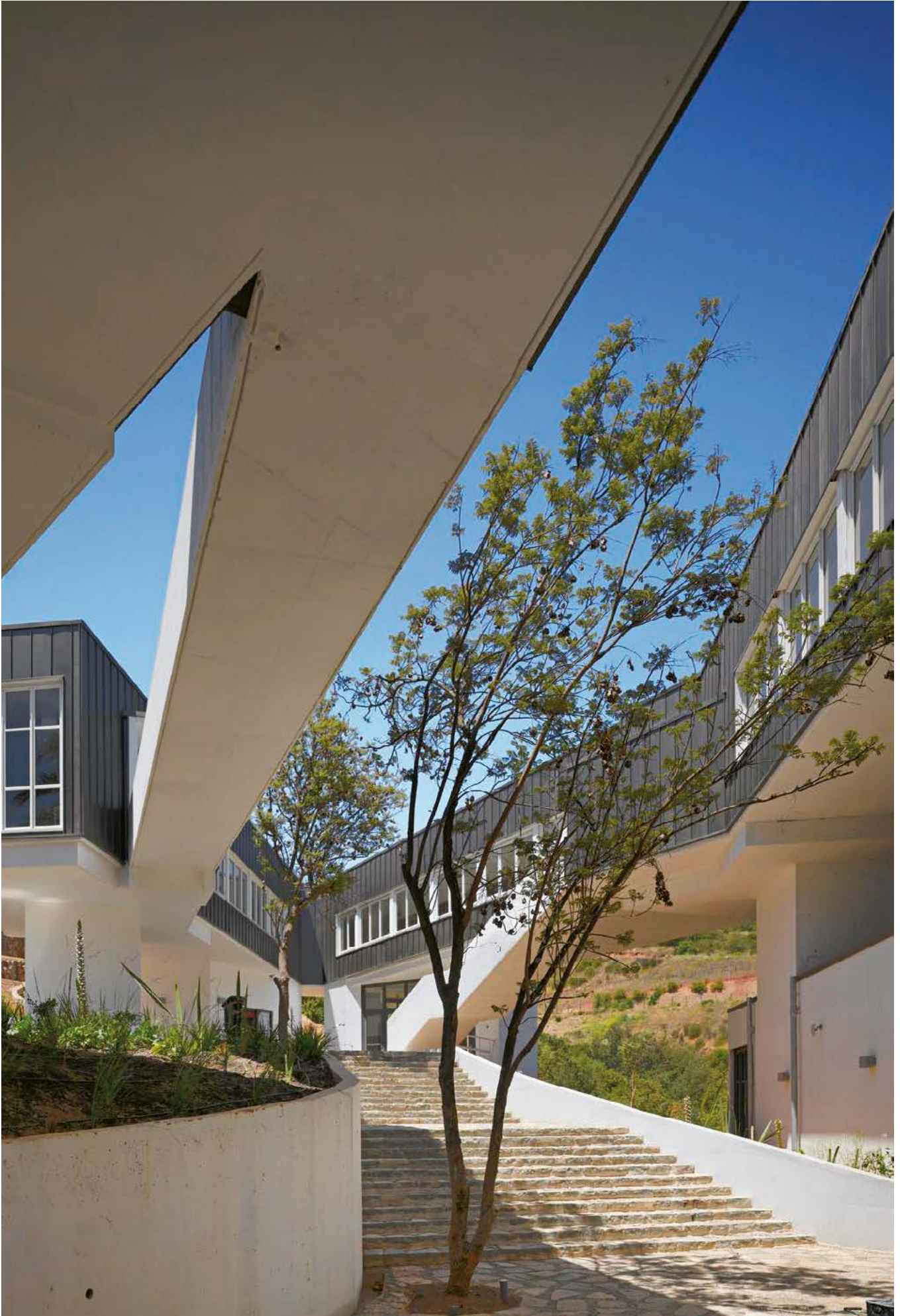
Universidad Adolfo Ibáñez, Campus Viña del Mar - Arquitectos: José Cruz Ovalle y Arquitectos Asociados - Productos: CD 430 SL, Piso Armstrong
