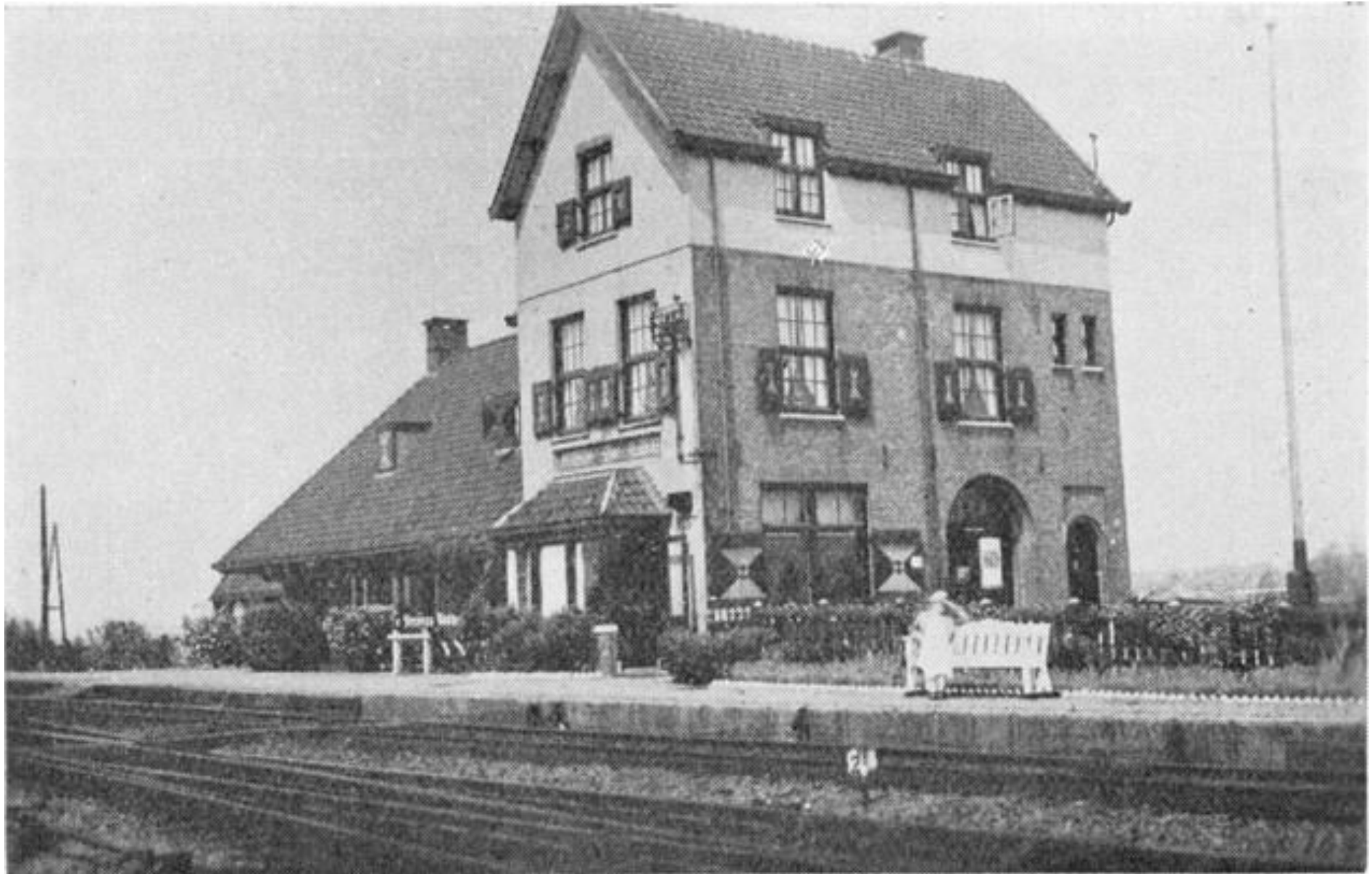
Station Kropswolde, na 1915 (circa 1936). De kozijnen, goten en windveren zijn in donkere tinten geschilderd en de ondervensters hebben luiken. Op het perron groenaanplant (uit Spoor en Tramwegen, www.stationsweb.nl )
