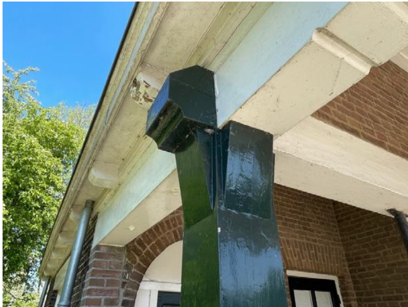
Kolom perronluifel bij sanitair (W)
