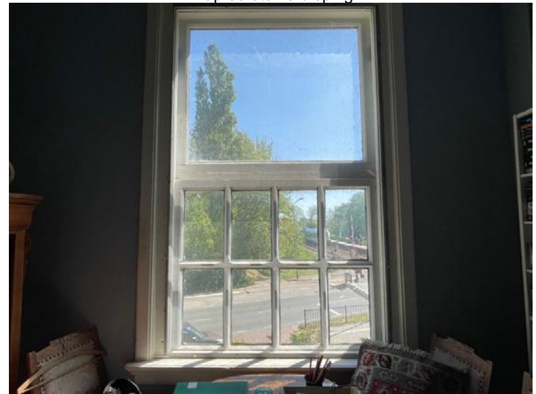
Restant raamroedes woning eerste verdieping
