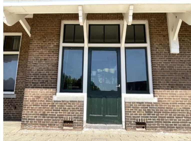
Deurkozijn naar voormalige wachtruimte (Z)
