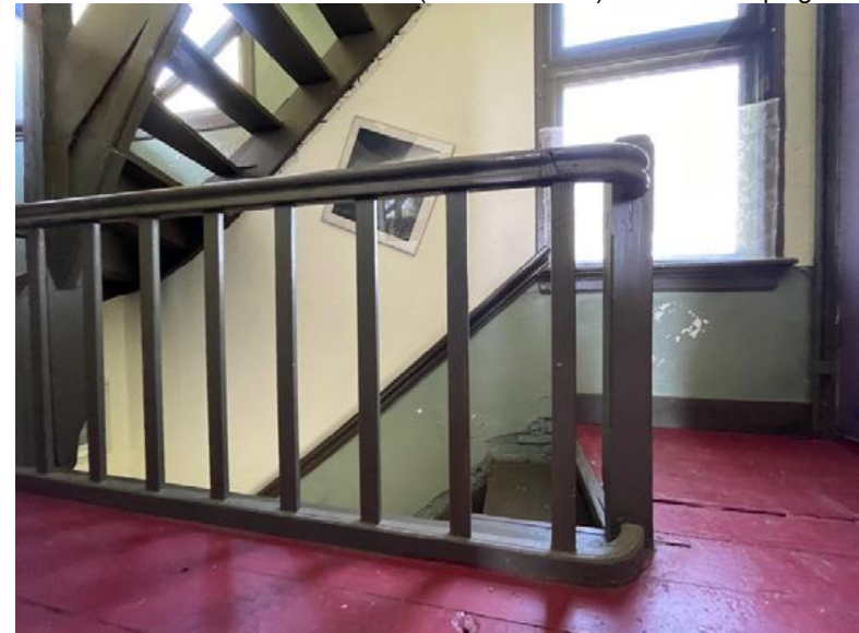
Balustrade eerste verdieping
