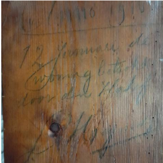
Markering van eerste bewoner 1916 in spantconstructie
