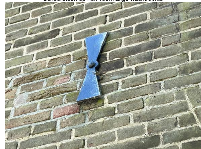
Een van de muurankers
