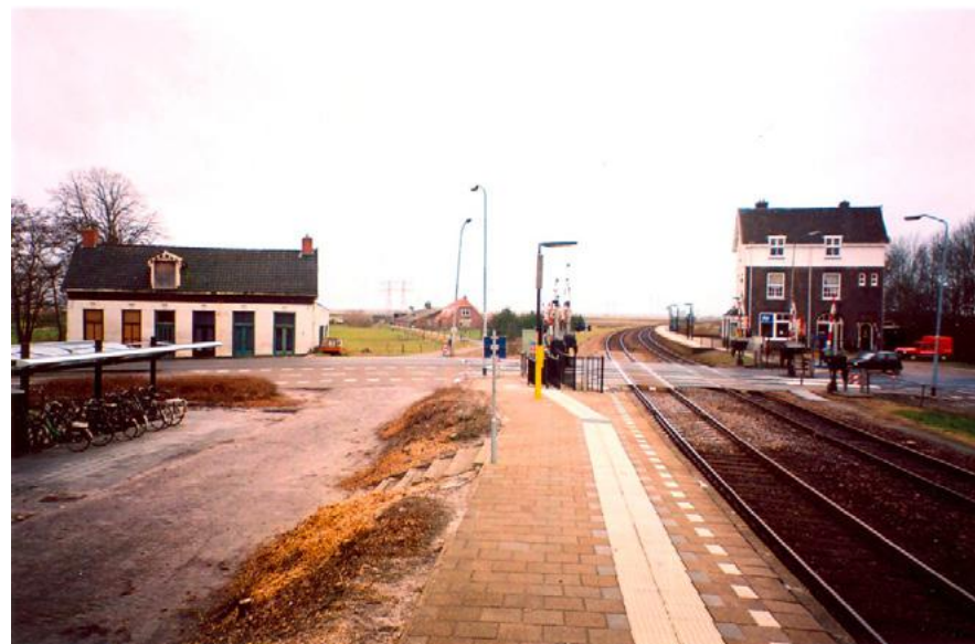
Zicht vanaf het zuidelijke perron, perron 2, op het stationsgebouw (rechts), en het stationskoffiehuis (links), 2003 (foto T. Smedes, coll. HAMG).
