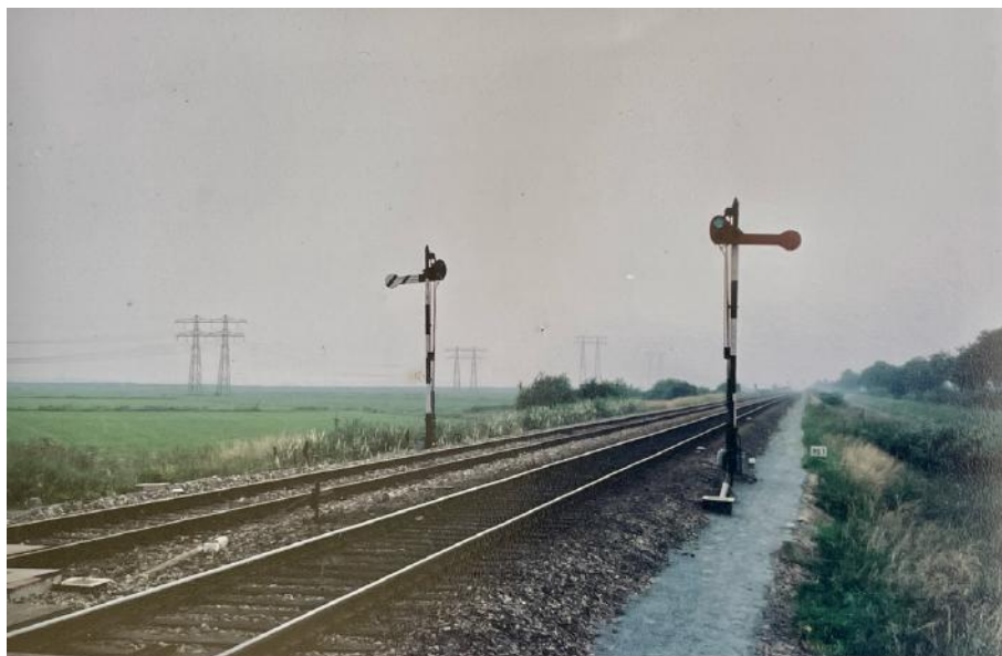
De seinen bij de voormalige overgang westelijk van het station, richting Groningen, ongedateerde opname (Coll. PAF)
