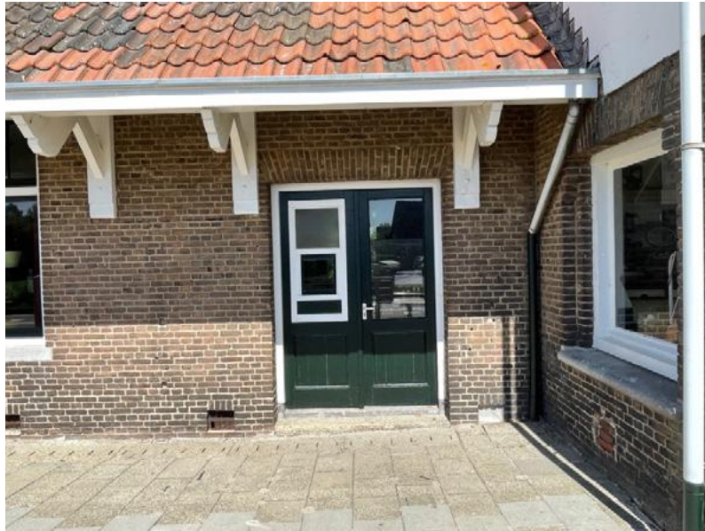
Deur voormalige ruimte bagage met raamluikje
