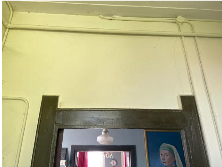
Doorgezette houten kozijnstijlen eerste verdieping
