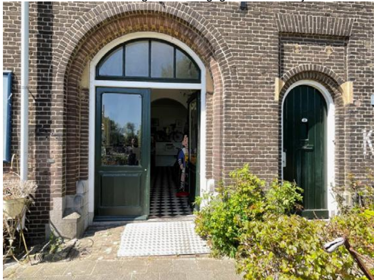
Deuren in oostgevel met rondboog
