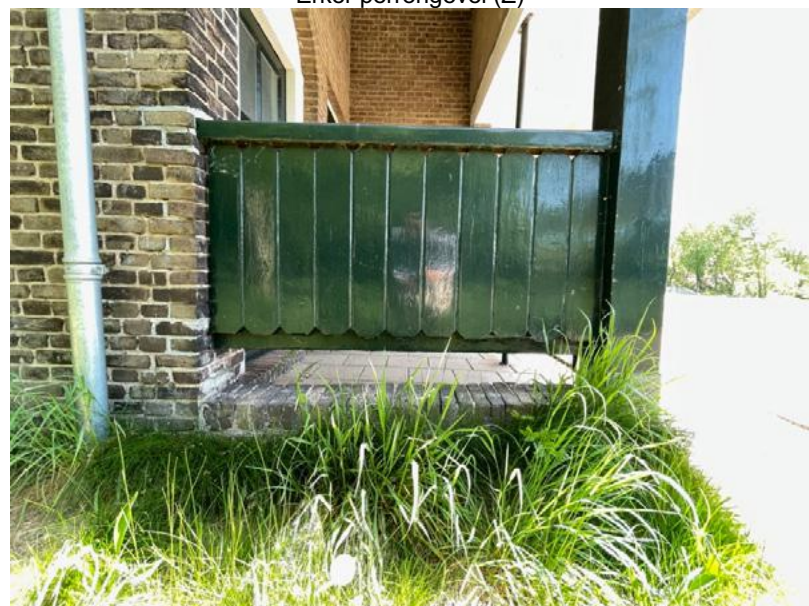
Houten hek bij sanitair (W)
