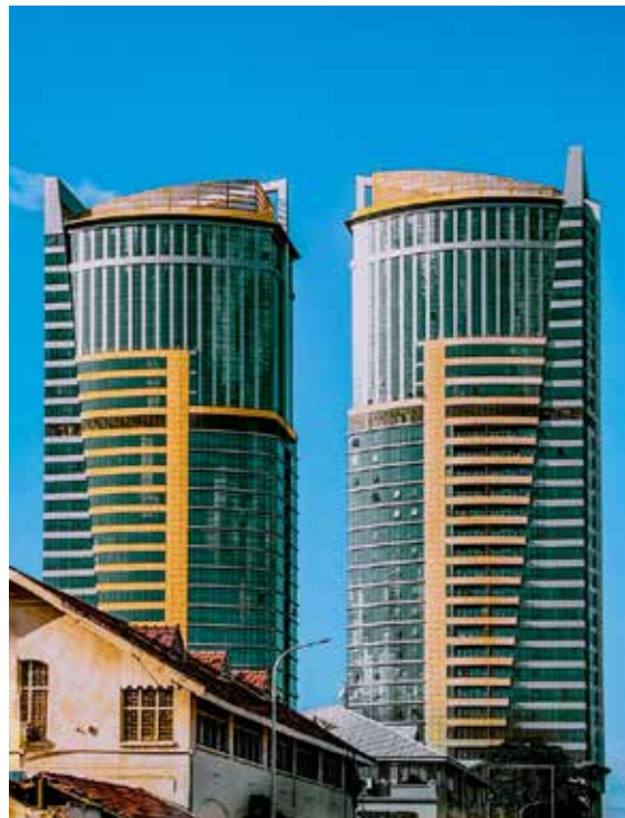
Majengo pacha ya PSSSF, Barabara ya Sokoine, Dar Es Salaam
