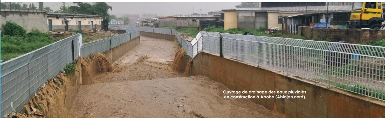
Ouvrage de drainage des eaux pluviales en construction à Abobo (Abidjan nord).
