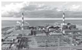
(Ảnh TTXVN via Lao Dong: Nhà máy Nhiệt điện Vĩnh Tân 3 là dự án điện than lớn nhất nằm trong Trung tâm Điện lực Vĩnh Tân, tỉnh Bình Thuận.)
