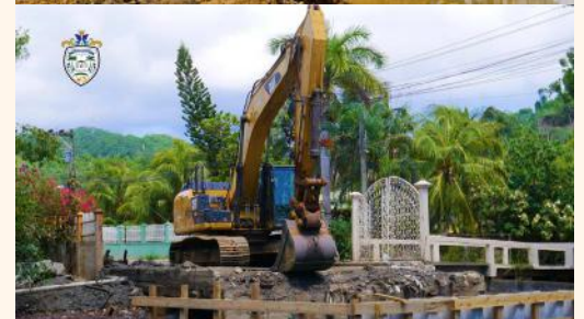
Así avanza la reconstrucción del Puente Grande en el sector de Willie Warren.
