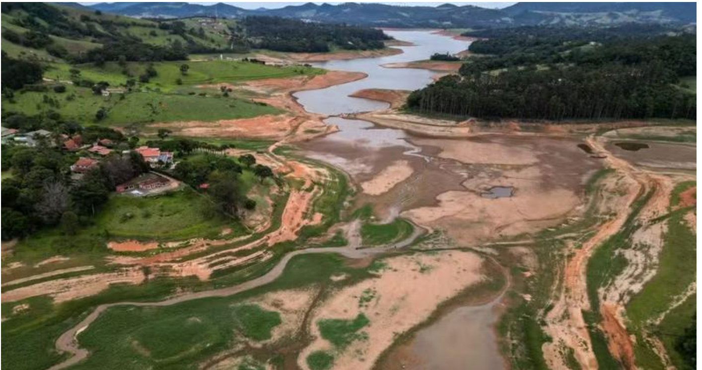
A BARRAGEM JAGUARI-JACAREÍ FAZ PARTE DO SISTEMA DE BARRAGENS DA CANTAREIRA DE SÃO PAULO, QUE ABASTECE 46% DA REGIÃO METROPOLITANA DE SÃO PAULO, EM DEZEMBRO — FOTO: NELSON ALMEIDA / AFP / O GLOBO
