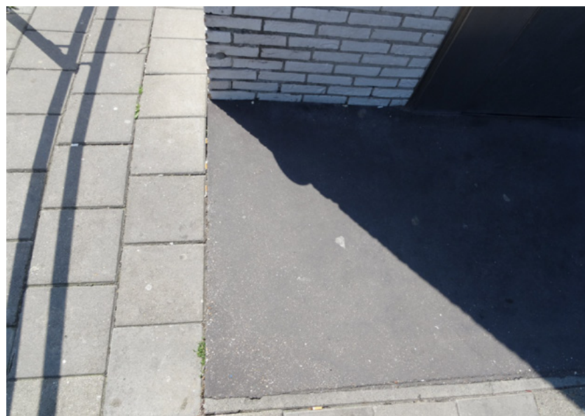
Afb. 5.4 De betonplaat sluit op perronniveau aan op de bestrating.
