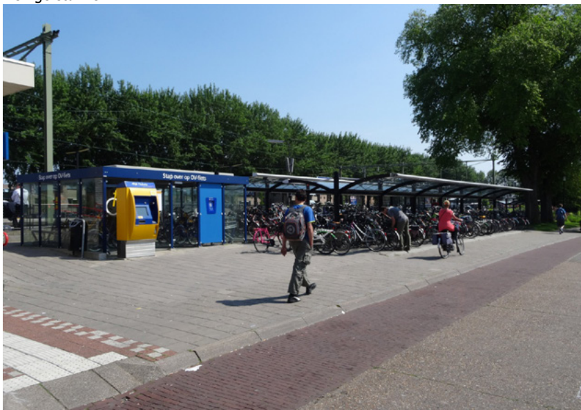
Afb. 4.29 De fietsenstalling aan de zuidzijde van het stationsgebouw.
