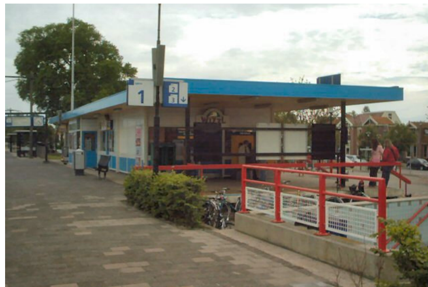
Afb. 4.15 Rechtsvoor is de oude entree tot de voetgangerstunnel zichtbaar. Dit is de enig bekende afbeelding waaruit de aanwezigheid van een tunnel blijkt. Foto 2005, coll. W. Bramer.
