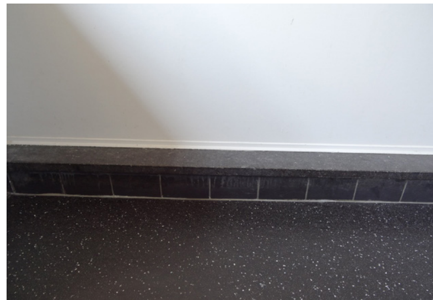
Afb. 5.36 De plint van hardsteenplaat op matzwart tegelwerk, langs de glaswanden in de wachtkamer.
