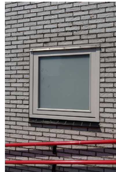
Afb. 5.29 Nieuw ingezet venster in de zuidwand.
