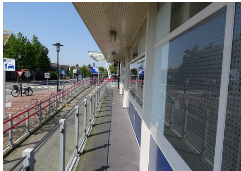
Afb. 5.30 De glaswand langs de straatzijde. Met witgeverfde stalen staanders en kozijnwerk en blauwe beplating in de borstwering. De ramen zijn afgedicht met webbing.
