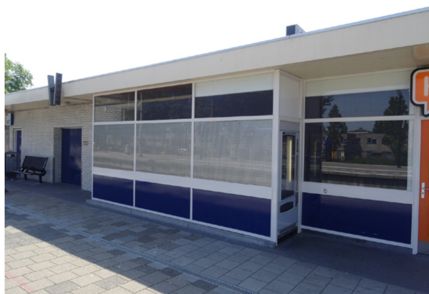
Afb. 5.31 De entree tot het vroegere plaatskaartenkantoor, in de perronuitbouw, is omgebouwd tot automatiek. Links de dichtgezette deuropening van de bagageruimte.
