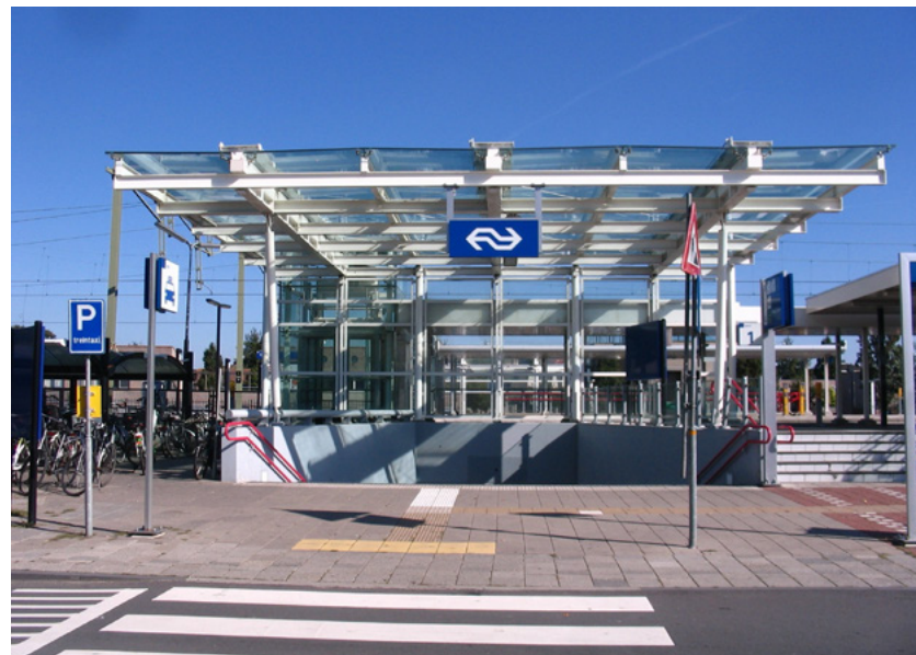
Afb. 4.16 De grootse entree tot de gerenoveerde reizigerstunnel. Foto 2013, coll. A.J. Travaille.
