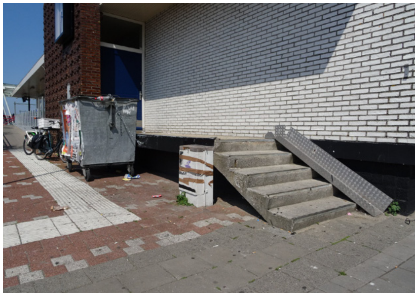
Afb. 5.26 Het gesloten muurvlak aan de straatzijde, aansluitend op de plint. Op de voorgrond de betonnen trap naar de entree tot de vroegere bagageruimte.
