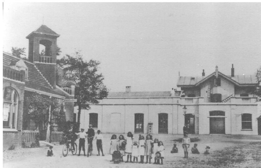
Afb. 4.2 De voorzijde van het station, met de grote zijvleugel, rond 1910. Op de voorgrond het stationsplein dat vermoedelijk grotendeels onverhard was. Coll. P. Collet.
