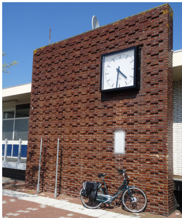
Afb. 5.32 De ornamentele wand, van donkerbruin geglaazuurde handvormbaksteen.
