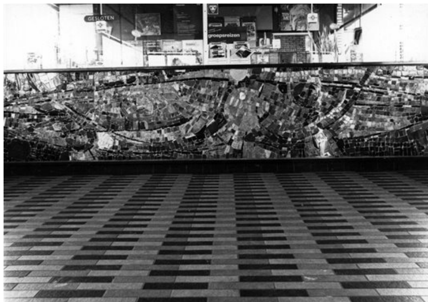
Afb. 5.15 De betegelde vloer te Schagen, in iets ander patroon dan Etten-Leur. De loketbalie heeft een fraaie invulling met een glas-mozaïek. Foto 1983, HUA cat.nr 154064.
