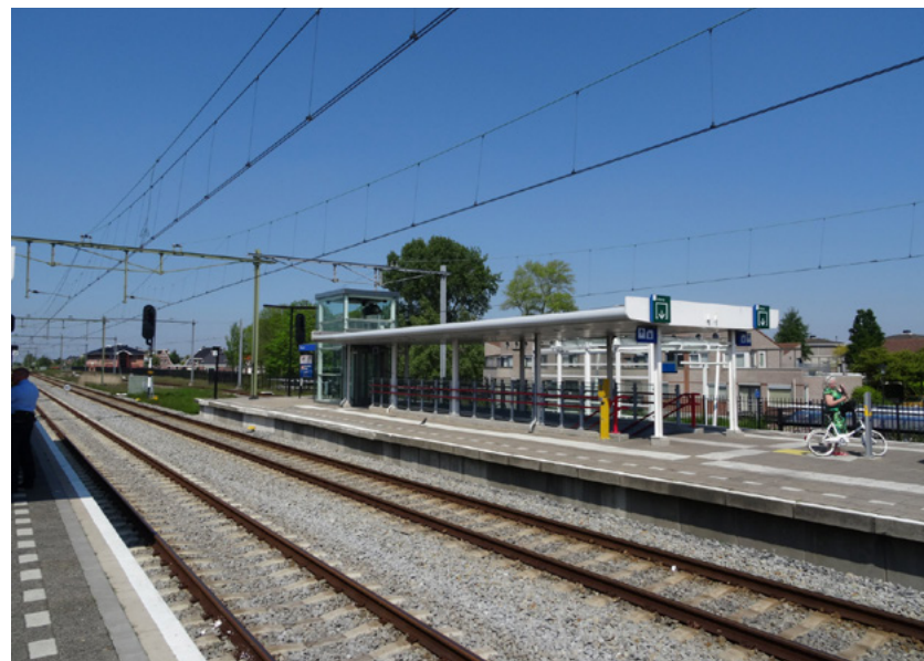
Afb. 4.22 Het recente liftgebouw en overdekte toegangstrap naar perron 2.
