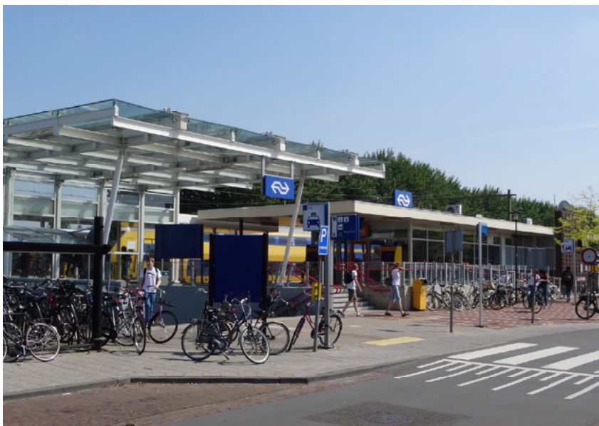
Afb. 4.20 Het centrale punt van het emplacement; het entreegebied van de reizigers-tunnel, met ernaast de overkapte voorruimte van het stationsgebouw.
