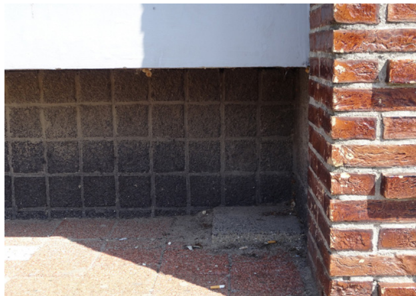
Afb. 5.3 De plint van station Schagen aan de straatzijde onder de betonplaat, met afwerking van granietkeien.
