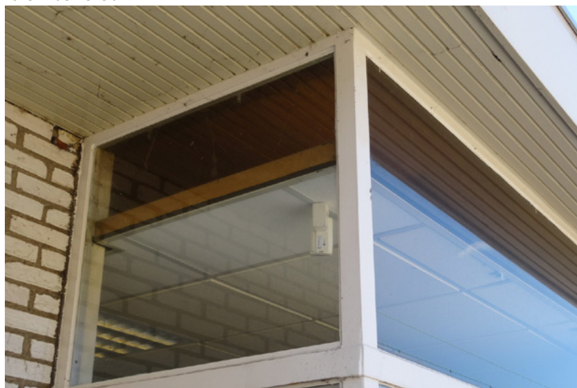
Afb. 5.6 Plafondafwerking te Schagen. Door het raam van de uitbouw aan het vroegere plaatskaartenkantoor zijn de beide plafonds zichtbaar; het verlaagde systeemplafond uit circa 1997 of 2009 en daarboven het bruine, houten schrotenplafond uit 1967. Dit plafond is (tegenwoordig) aan de buitenzijde witgeschilderd .
