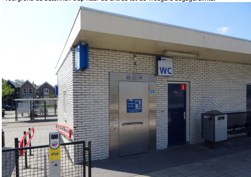
Afb. 5.27 De gesloten zuid- en oostwanden, met witgeglazuurd handvormbaksteen. In de oostwand aan perron 1 bevindt zich links de deur tot de openbare wc en ernaast de deur tot een technische ruimte.
