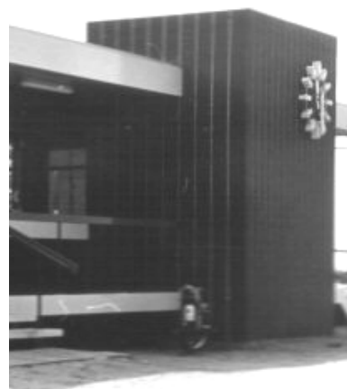
Afb. 5.11 Het metselverband op de baksteenwanden te Heerhugowaard. Foto 1967, coll. W. Bramer.
