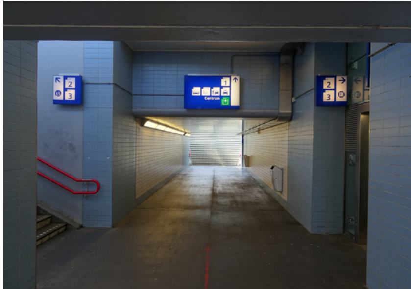
Afb. 4.24 De reizigerstunnel, gezien richting stationsplein. Links en rechts de trap en lift naar perron 2.
