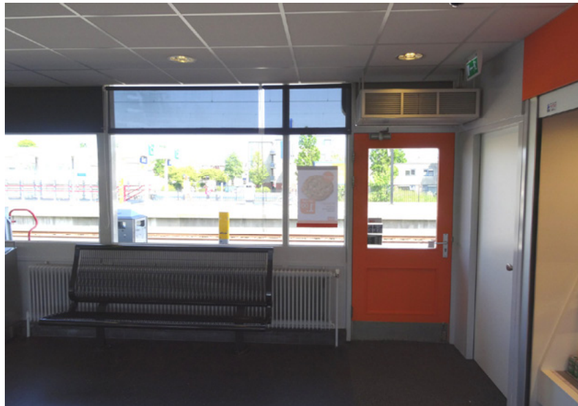
Afb. 2.11 Rechts de ver naar voren geplaatste tussenwand met toonbank uit 2009. Middenvoor de toegangsdeur naar het perron. De historische lichtheid en transparantie van het gebouw zijn afgenomen door verlaagd plafond en lichtwerende rolgordijnen.
