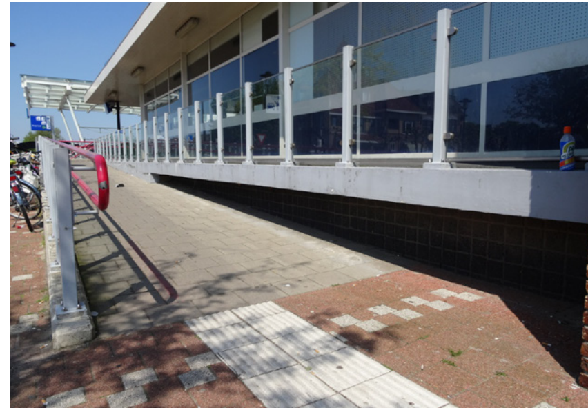
Afb. 5.24 De plint van granietkeien onder de betonplaat. De plint valt tegenwoordig grotendeels weg achter de lange hellingbaan.
