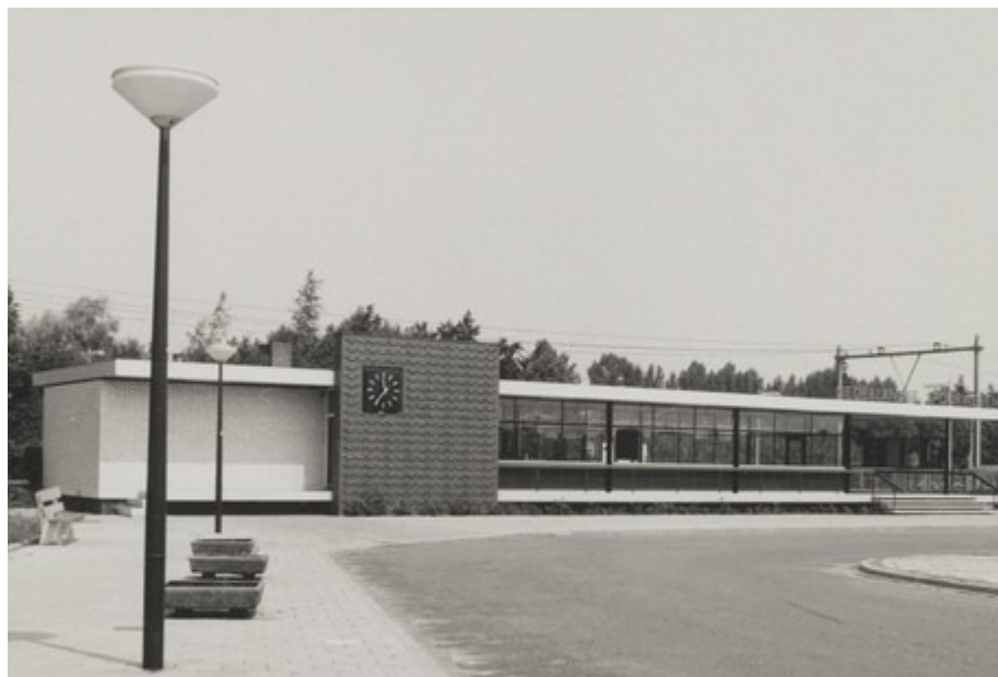
Afb. 5.7 Het station te Etten-Leur. Links de muur met witgeglazuurd baksteen. Rechts de transparante wachtkamer, met donker hardglazen borstwering. Foto 1965. Coll. Regionaal Archief Brabant.
