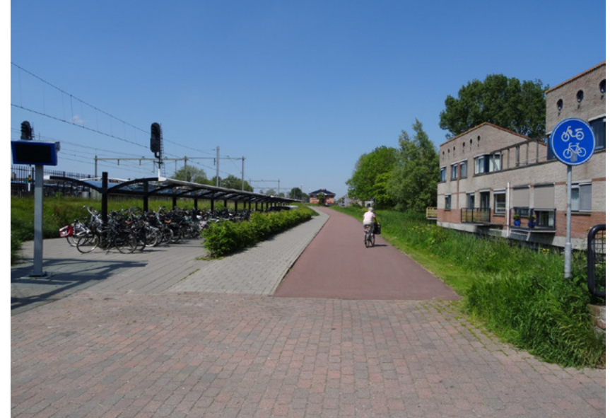
Afb. 4.26 De noordoostelijke fietsenstalling, met ernaast het nieuwe openbare fietspad op de grens van het emplacement.
