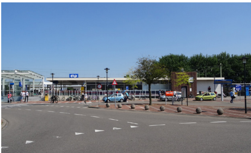
Afb. 4.19 Aanzicht van het station vanuit de Landbouwstraat. Op de voorgrond de openbare weg rond het plein, daarachter het busstation en de K&R-strook voor het stationsgebouw. Het stationsgebouw gaat schuil achter de verschillende inrichtingselementen en heeft daardoor weinig zeggingskracht op het emplacement.
