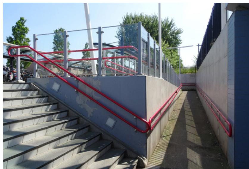
Afb. 4.17 De nieuwe hellingbaan bij de oostelijke entree tot de reizigerstunnel.
