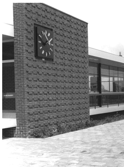
Afb. 5.12 Het siermetselwerk in banden op de baksteenwand te Etten-Leur. Foto 1965, HUA cat.nr 150301.
