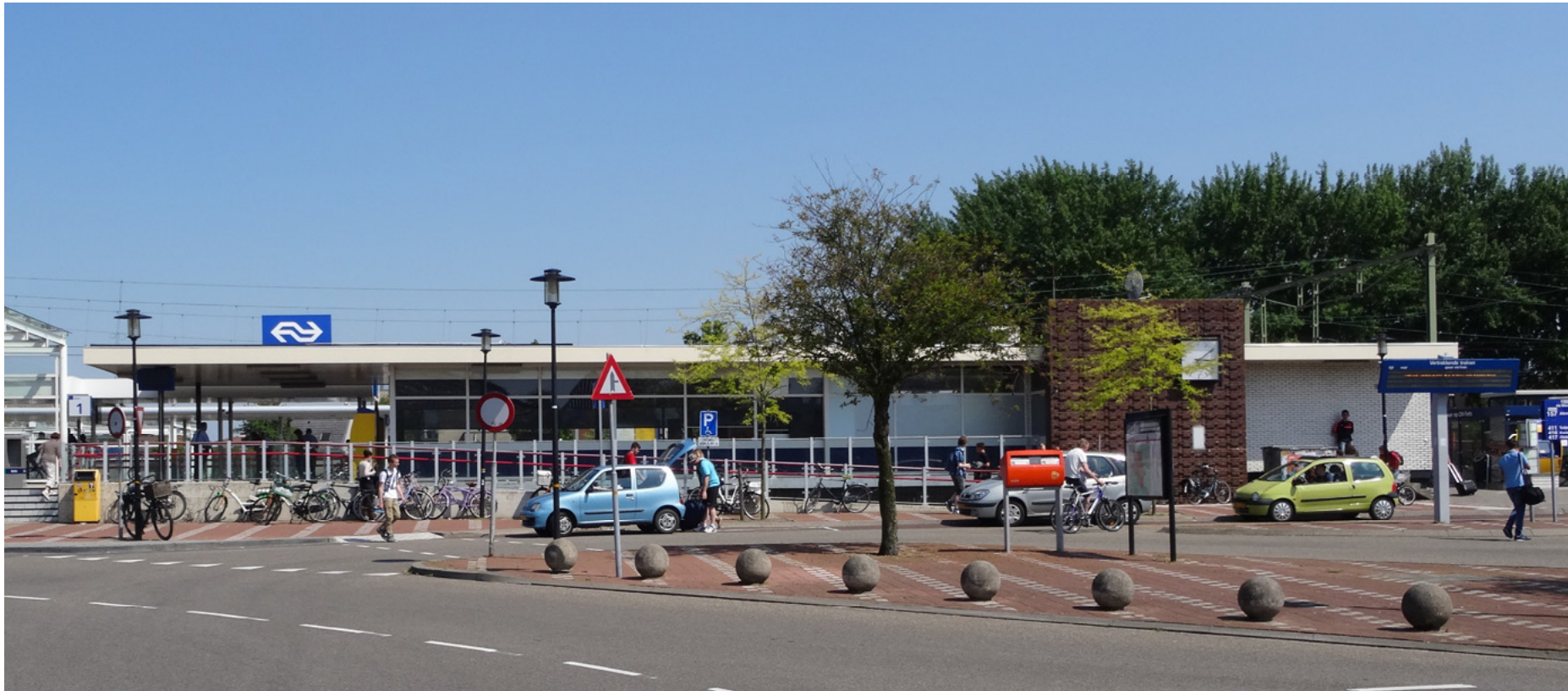
Afb. 5.22 De straatgevel van het stationsgebouw. Van links naar rechts de publieksdelen; de overkapte buiten-wachtruimte, de glaswand-gevel van de wachtruimte annex Kiosk. Doorzicht door de wachtruimte wordt verhinderd door de dichte rolgordijnen. Vervolgens de dichtgeplakte ramen van de personeelsruimte en magazijn, de ornamentele wand van bruin-geglazuurde baksteen met stationsklok en de buitenwand van wit-geglazuurde baksteen rondom bedrijfs- en technische ruimten. Delen van de gevel, met name van de ornamentele wand worden aan het zicht onttrokken door inrichtingselementen en jonge bomen.
