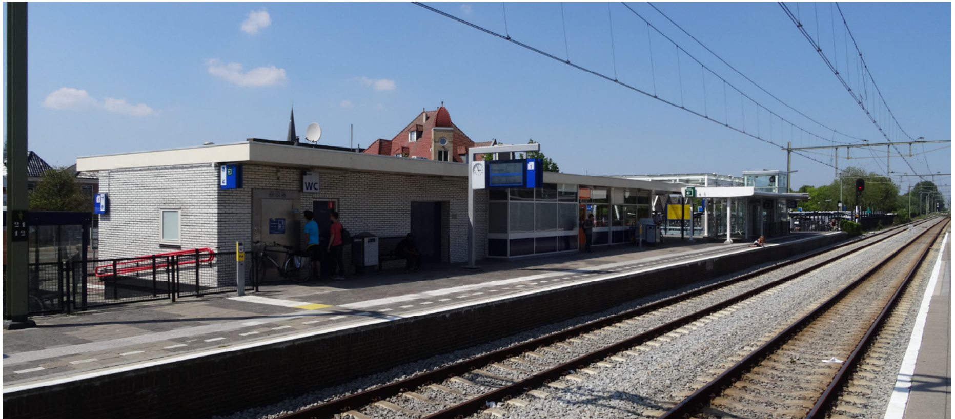
Afb. 5.23 De perrongevel van het stationsgebouw. Op de voorgrond de gesloten muren van wit-geglazuurde baksteen. Hierbinnen bevinden zich, tot en met de dichtgeplakte glazen uitbouw van het vroegere plaatskaartenkantoor, van links naar rechts de openbare wc-ruimte, technische ruimten en personeelsruimte voor de Kiosk. Daar aansluitend ligt de glazen ruimte van de op openingstijden toegankelijke wachtruimte annex Kiosk.
