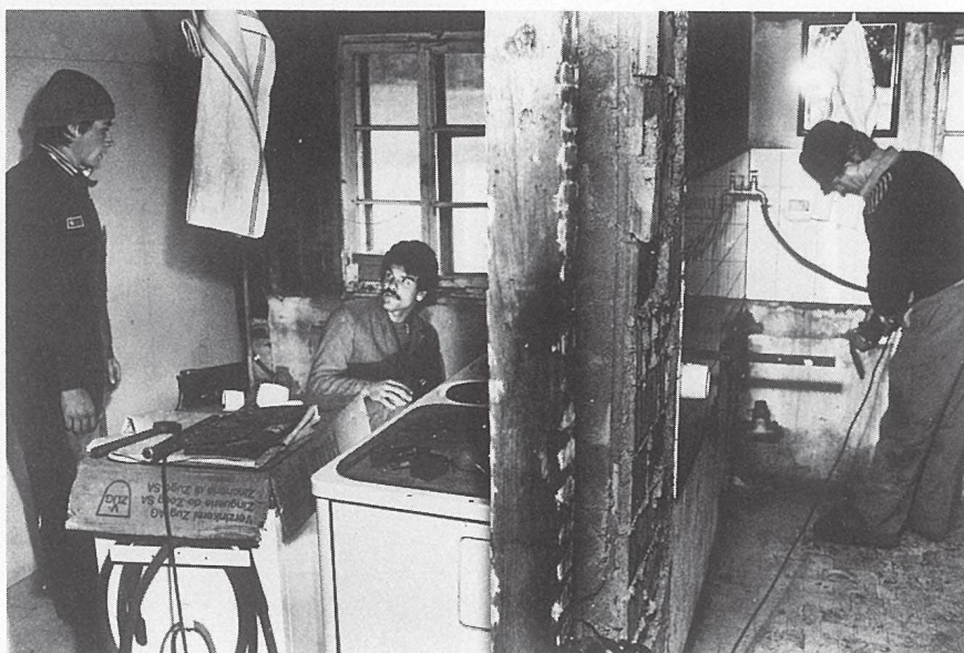
AP- und UP-Installation in Holzwerk.
