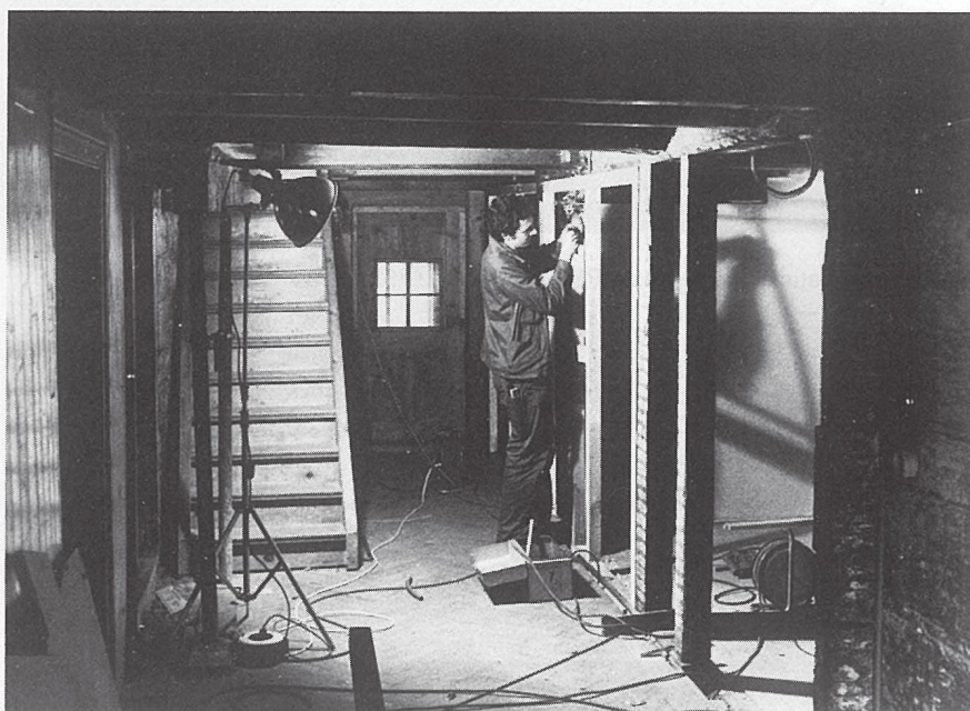
AP- und UP-Installation in Holzwerk.
