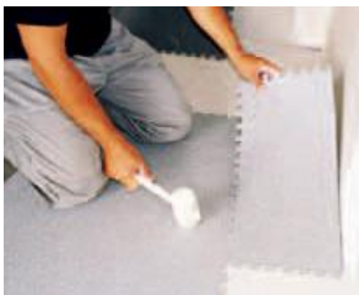
Lamas Clic System Attraction, GTI... > losetas y lamás únicas autoportantes, sin adhesivos.
