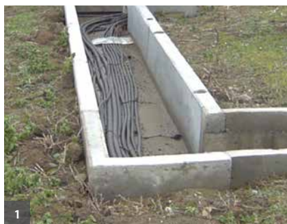
Exemple d'utilisation : Angle à 90°
