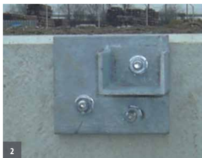
Utilisation de socle préposé pour un angle à 90°
