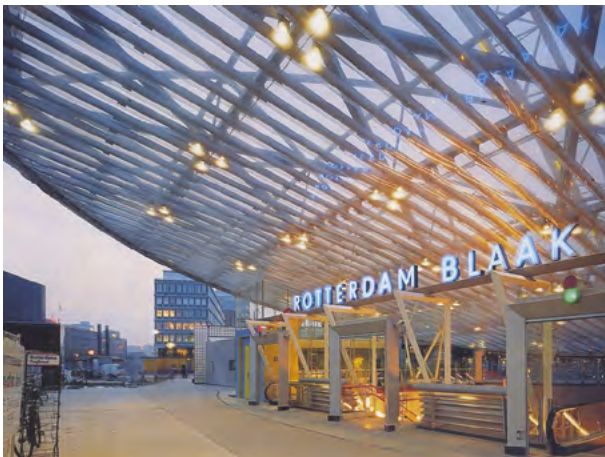
Station Rotterdam Blaak uit 1993 (bron: Douma, 1998).
