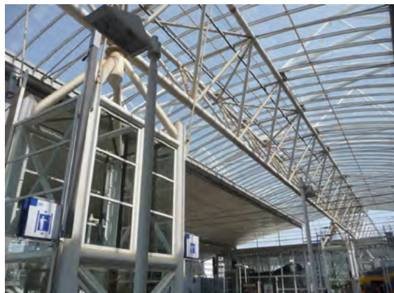
Stationskap op vakwerkligger en liftschachten.
