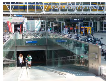
Stationsplein zeezijde met fietskelder.
