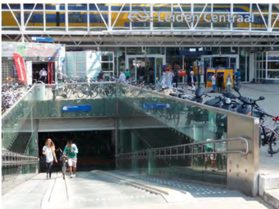
Toegangen boven- en ondergrondse fietsenstallingen aan de zeezijde.
