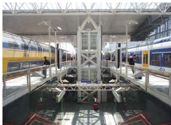
Glazen liften en grote vides brengen daglicht tot diep in het gebouw.
