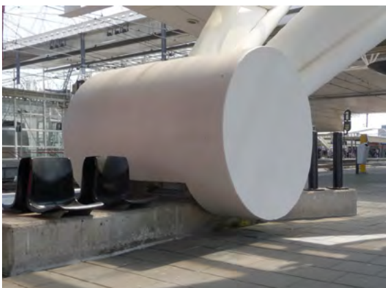
Trommelvormige schuifoplegging.
