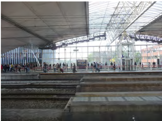
Gebogen stationskap met lichtstraat.
