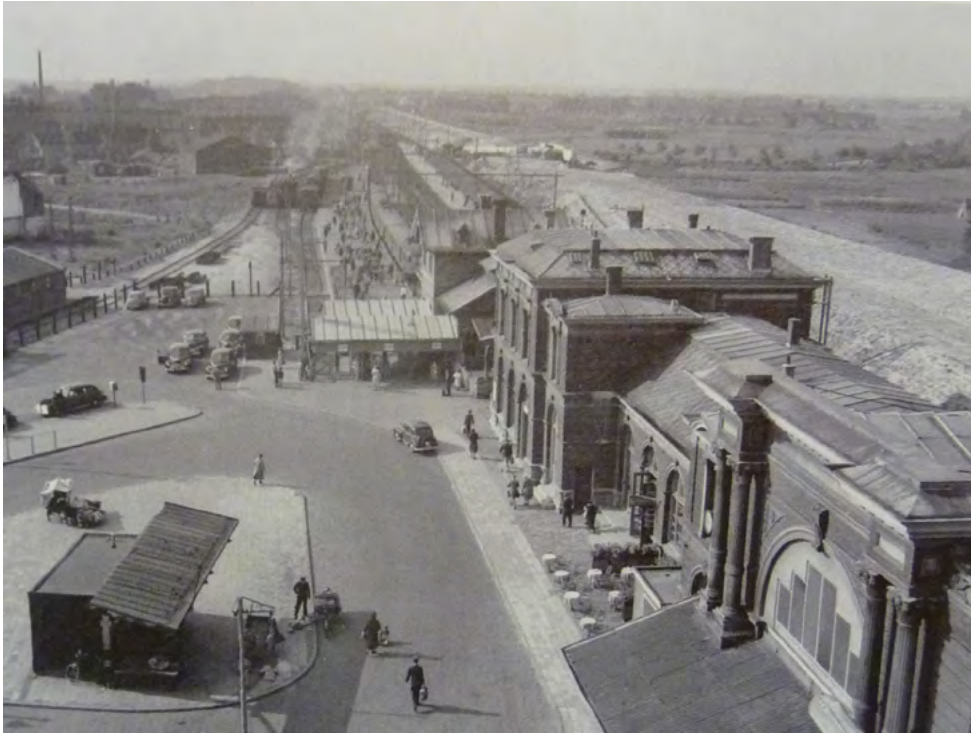
De aanleg van het hoogspoor in 1951: zie het dijklichaam rechts van het station. Het oude station is nog niet gesloopt (bron: Kruidenier 2009).
