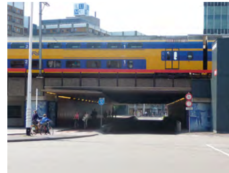
De Joop Walenkamptunnel voor fietsers en bussen door het hogespoor.
