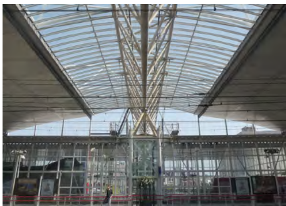
De lichtstraat en glazen frontgevels als richtinggevende elementen voor de reiziger.
