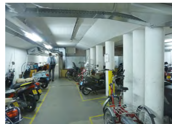
Voormalige bagagetunnel tussen de fietsenstallingen aan de stads- en zeezijde.
