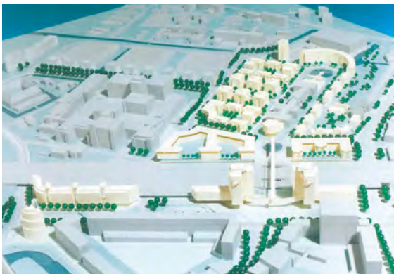
Winnende inzending van MABON i.s.m. Hoogstad Van Tilburg architecten (Rotterdam) en Articon (Amersfoort): vlnr maquette, vogelvluchtperspectief en voorgevelaanzicht. Belangrijkste ingrediënten: tweezijdig station, gelijkvloers voetgangersdomein via passage, afz. fiets- en bustunnel, twee kantooortorens aan de stadszijde en autotunnel voorlangs het station (bron: alle afbeeldingen op deze pagina zijn afkomstig uit Stadswerk (1989), nr. 25, maart).
