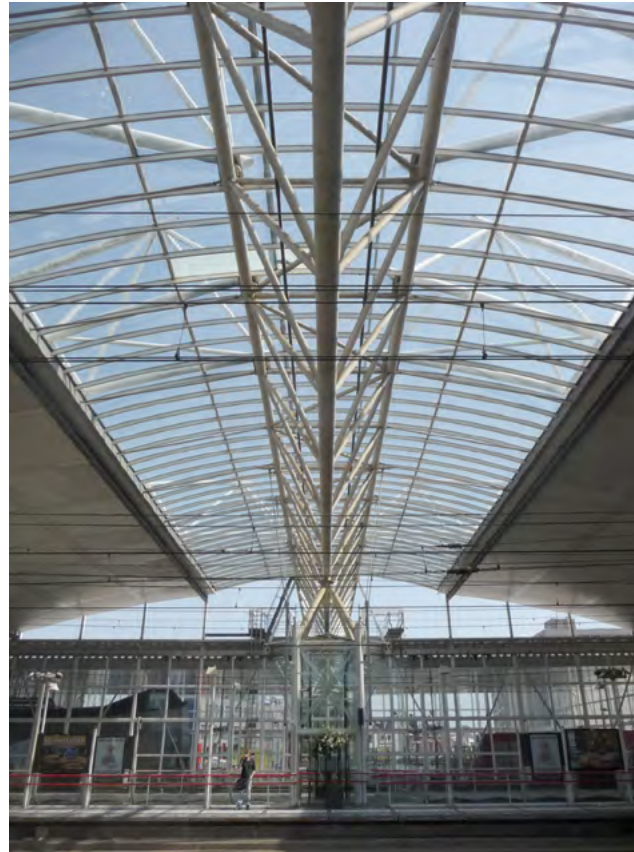
De stationskap met lichtstraat versterkt het verbindende karakter van het station, in de dwarsrichting van de sporen
