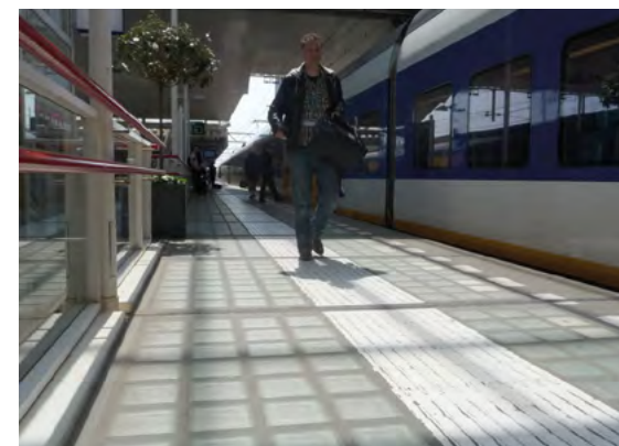
Glazen bouwstenen in de perronvloer laten daglicht door naar de onderliggende passage.
