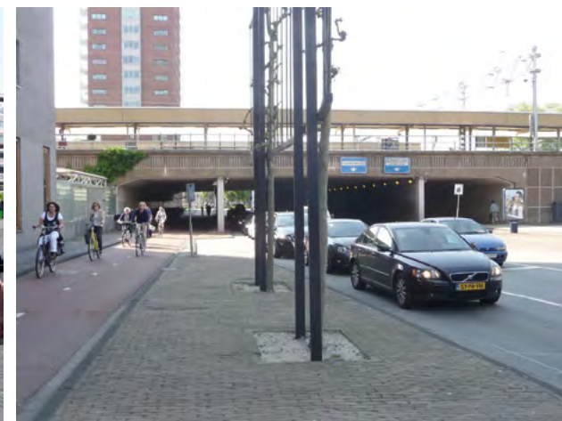
Spoorwegviaduct van Schuttersveld richting Rijnsburgerweg.
