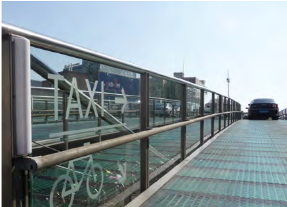
Taxi: de taxistandplaats is gesitueerd op het gebogen glazen dak van de onbewaakte fietsenstalling. Daar weer onder loopt de autotunnel: meervoudig grondgebruik.
