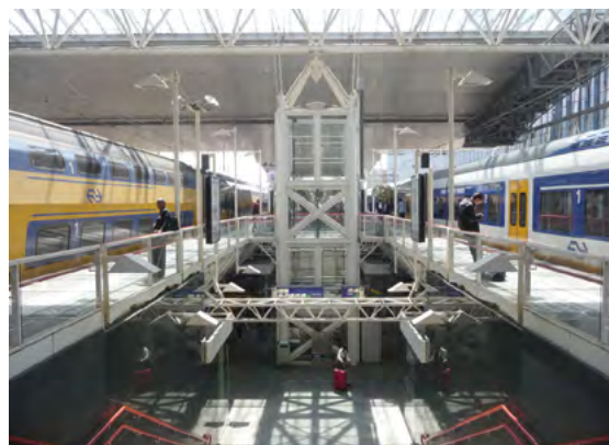
Vakwerkligger op een glazen liftschacht.
