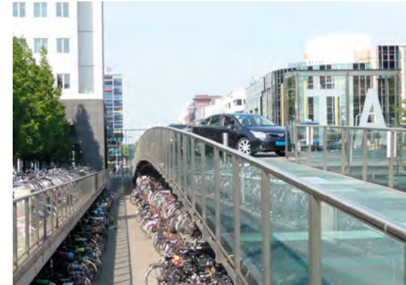
Taxi: de taxistandplaats is gesitueerd op het gebogen glazen dak van de onbewaakte fietsenstalling. Daar weer onder loopt de autotunnel: meervoudig grondgebruik.
