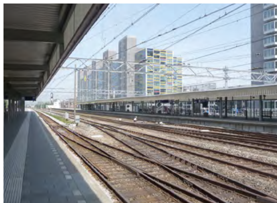
De sporen 5 en 8 langs de eilandperrons en de doorgaande niet-perronsporen 6 en 7 in het midden.
