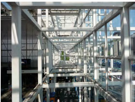
Stalen frame voorgevel: lengtedoorzicht.
