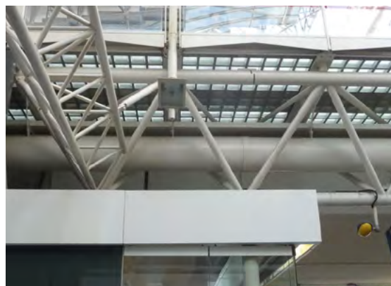
Vakwerkliggers als constructie-elementen rond de vides.
