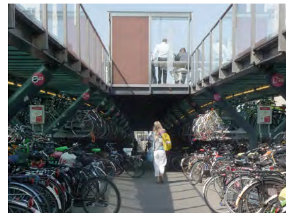
Onbewaakte fietsenstalling stadszijde is gesitueerd onder de taxistandplaats.
