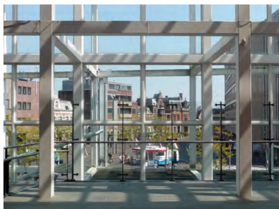
Stalen frame voorgevel: dwarsdoorzicht.
