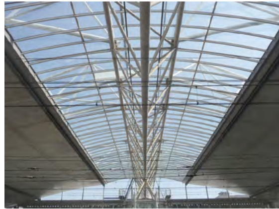
Allesoverheersende constructie-esthetiek van vakwerk, liggers en bogen die op spectaculaire wijze de constructieve werking tonen.
