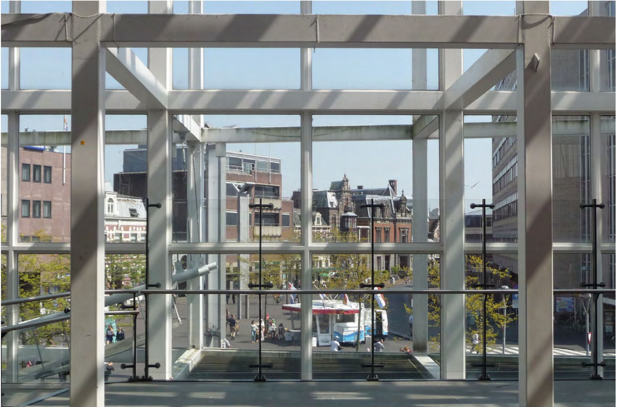
Voorgevelframe met doorzicht richting Stationsweg.
