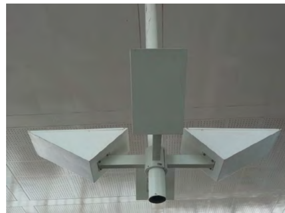
Wit staal: lichtarmaturen en plafond.
