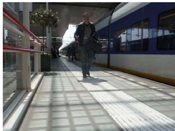
Perronvloer van glazen bouwstenen boven de passage.
