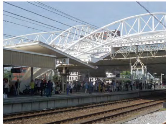
Diagonale vakwerkliggers aan buitenzijde stationskap.
