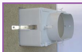
Détail patte de fixation
