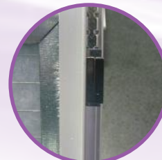
Détail fermeture par aimants
