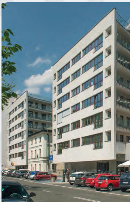
Okazały nowoczesny apartamentowiec obudowujący dwa dawne domy przy ulicy Solec 24 z tablicą pamiątkową. Fot. J. Gaździcki
