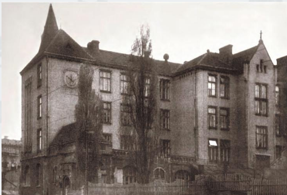
Szkoła na ulicy Drewnianej w 1937 roku
