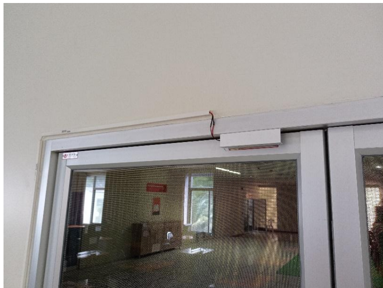
ภาพที่ 2 การติดตั้งกลอนแม่เหล็กที่ประตู
