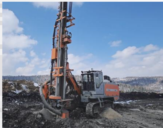
D490A 俄罗斯·铁矿项目 D490A Russia Iron Ore Project
