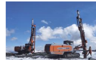
工程建设 Construction
