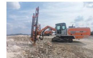
工程建设 Construction
