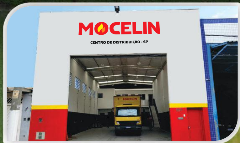
Centro de Distribuição em São Paulo-SP
