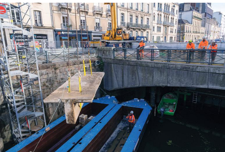
↑ Les gravats sont évacués sur des barges par voie fluviale jusqu'au site de stockage, situé 4 km en aval, route de Lorient, où ils seront recyclés.
