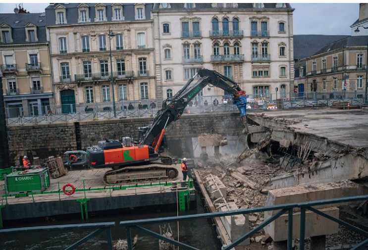
↑ Pour détruire la dalle, une spectaculaire pelleteuse, posée sur un ponton flottant, est entrée en action mi-décembre. C'est elle qui va grignoter petit à petit le parking, à raison de 5 mètres par jour jusqu'au printemps.
