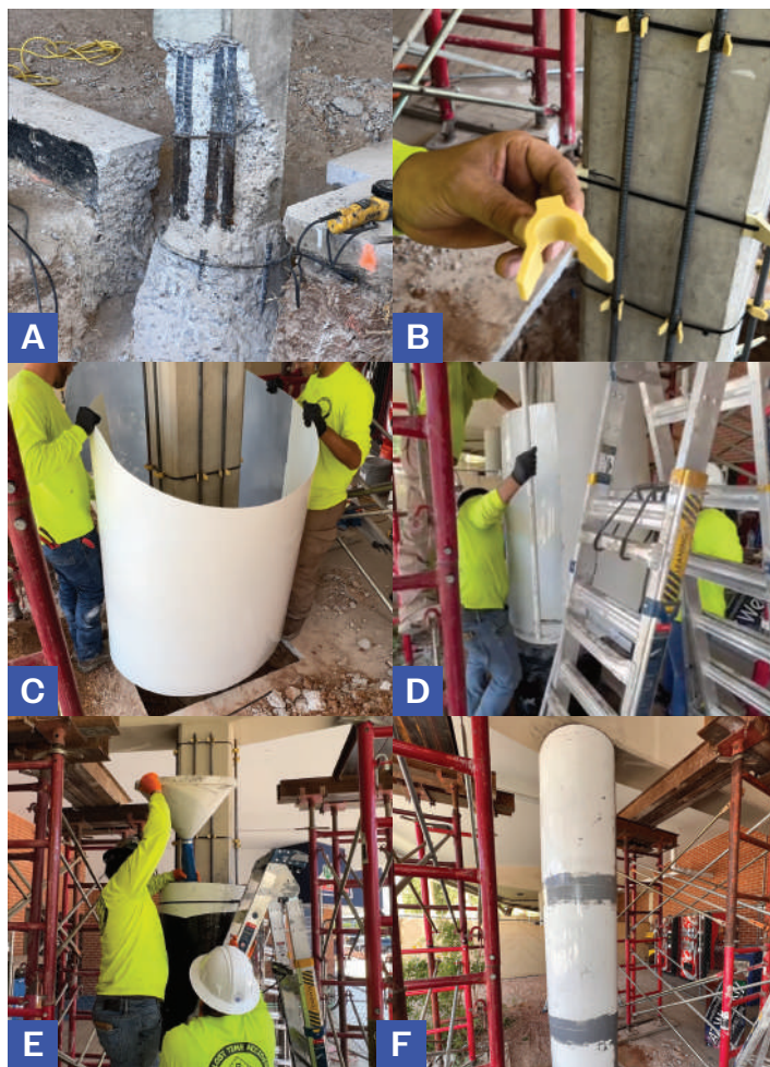
Fig. 1: Reparación de una columna deteriorada con un laminado de polímero reforzado con fibra (FRP): (a) superficie dañada; (b) instalación de los espaciadores y las barras de refuerzo; (c) envolver el primer laminado para formar un cascarón; (d) envoltura de laminados adicionales; (e) rellenar el espacio anular; y (f) reparación terminada.
