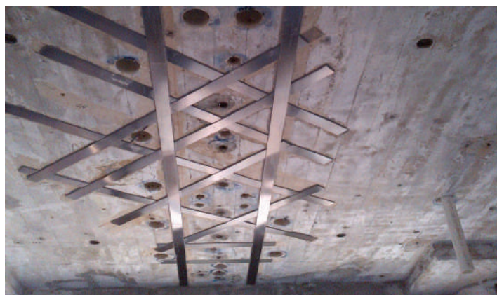
Se instalaron placas de fibra de carbono para reforzar la estructura
