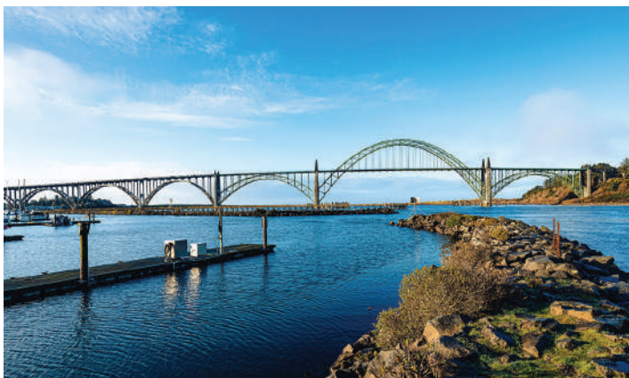
Rehabilitación de la Protección Catódica del Puente de la Bahía de Yaquina
