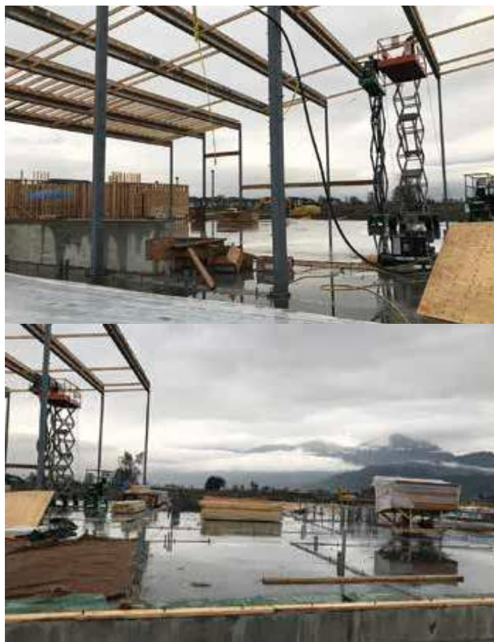
Fig. 1: Centro Comunitario y de Salud SAY en Chilliwack, BC, Canadá, durante la construcción. El suelo de concreto del gimnasio incluía Hard-Cem para mejorar la resistencia a la abrasión.
