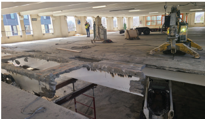
Demolición controlada remotamente
