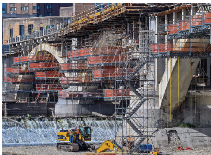
El acceso a la subestructura requirió un complicado andamiaje suspendido y ataguías drenadas. (Foto cortesía de Joe Szurszewski Photography)
