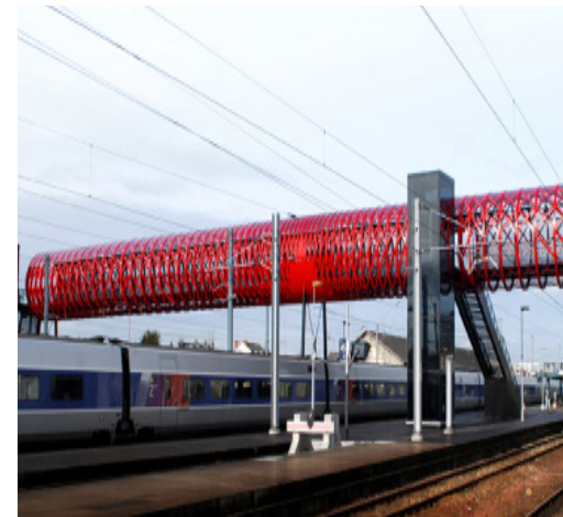
Railway footbridge, Roche-sur-Yon Пішохідний міст на залізничній станції, Ла-Рош-сюр-Іон
