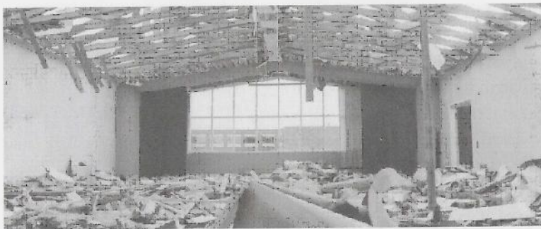
Nedrivning af FDF-huset. Den nye socialforvaltning i baggrunden.
