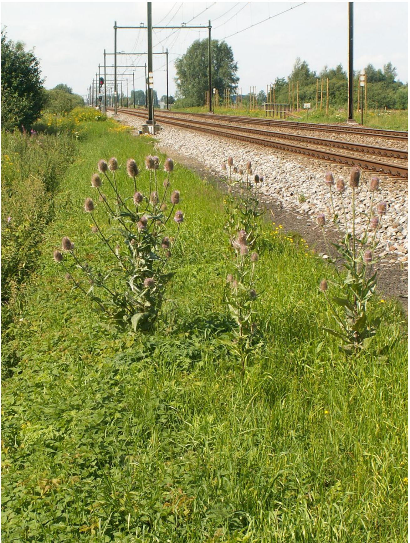
Opbouw van de spoorberm: v.r.n.l. ballastbed, inspectiepad, grazige berm, ruigte, struweel.
