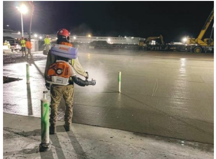
Fig 1: La nebulización temprana es necesaria para mantener la apariencia reflectiva del concreto húmedo. Con la naturaleza cambiante del cemento Tipo IL, los contratistas deben considerar los factores ambientales y mantener las superficies del concreto continuamente húmedas, evitando que el agua se acumule (foto cortesía de Ben Wiese).
