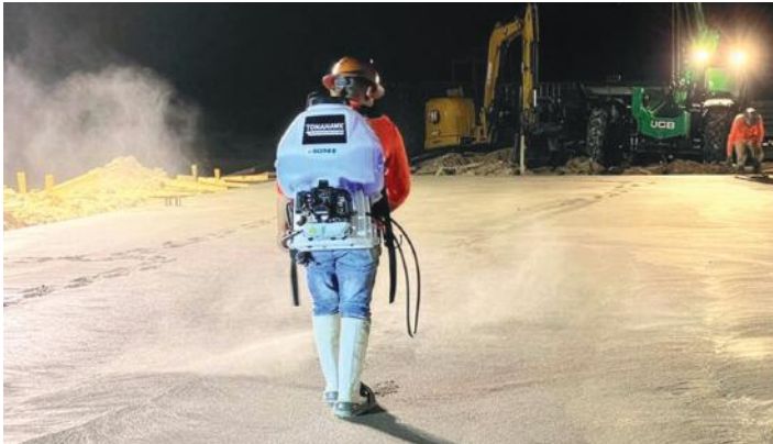
Fig 2: Basándose de mediciones en tiempo real, los contratistas en concreto deben ajustar sus tiempos de fraguado. Aquí, un trabajador atrapa el agua de sangrado en la superficie del concreto bajo una membrana uniforme de un retardante de evaporación de aplicación líquida. Es fundamental aplicar el retardante de evaporación después del enrasado y entre las diferentes operaciones de allanado (foto cortesía de Ben Wiese).
