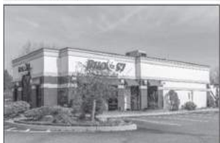
Tiệm ăn PHỞ 57 – 1885 NJ Rte 57, Hackettstown, NJ 07840 – Giá bán $330,000. Tiệm rộng khoảng 3,000 sqft với sức chứa 70 người, xây năm 2000, nằm trong Mansfield Shopping Mall, kiểu drive-thru và eat in. Lease còn 7 năm, giá thuê $7,500 triple nets. Xin liên lạc ngay để biết thêm chi tiết.
