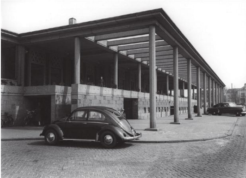
Terras onder pergola met helemaal links in het basement de trap naar het terras, middenin de opening naar de trap naar de hal en rechts nog te zien de opening naar de fietsenkelder
