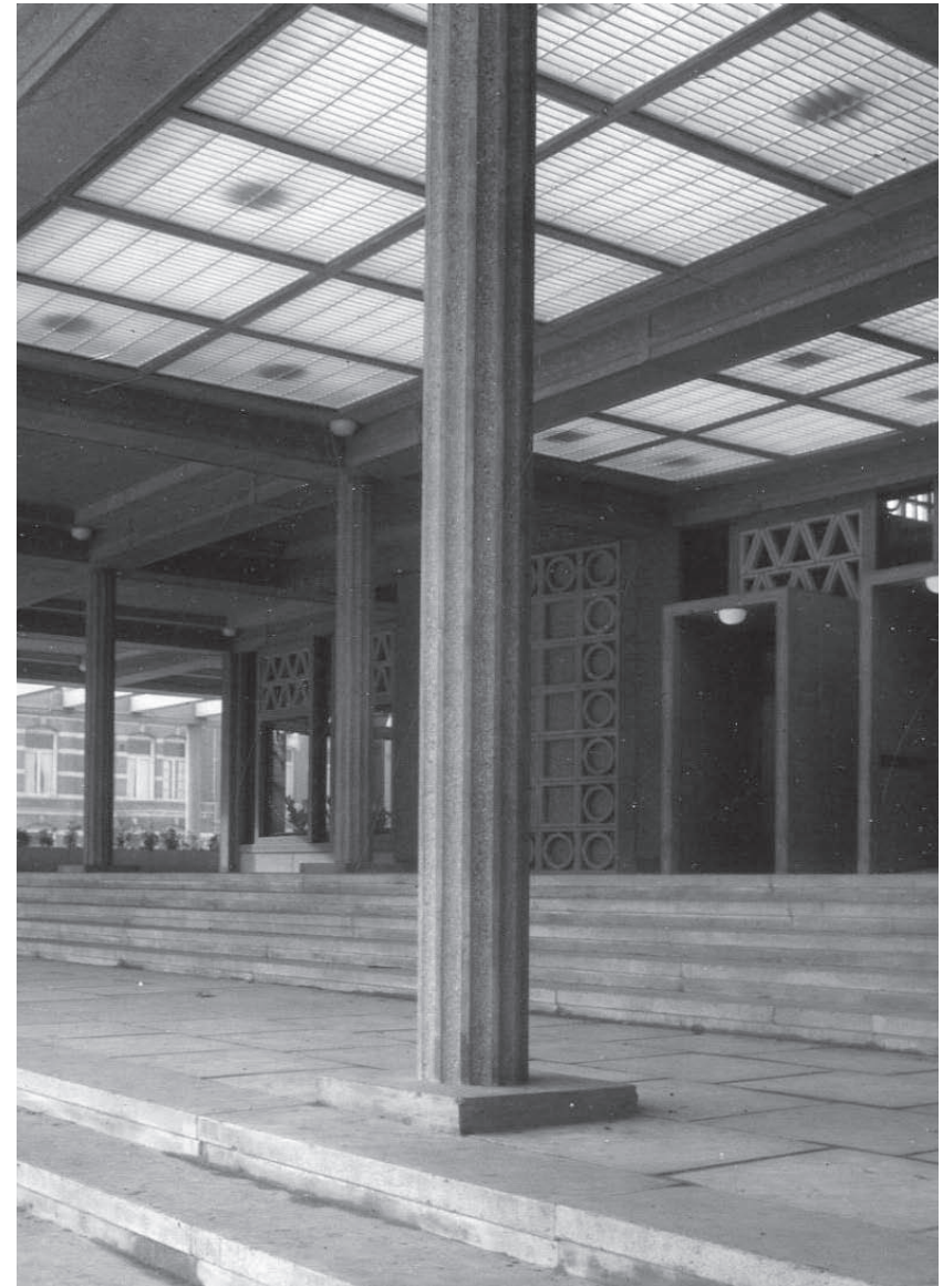
Ronde gecanneleerde zuil in station Enschede 1950, hoofdentree onder luifel
