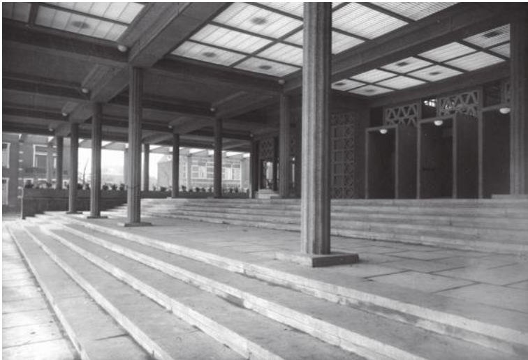
Peristyle met trappen naar de ingang
