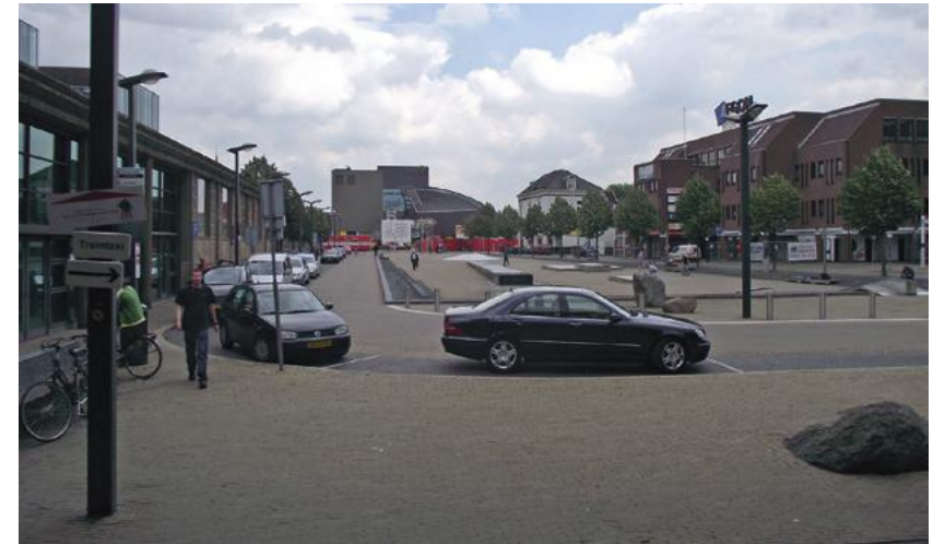
Het Stationsplein met in de verte het Muziekkwartier in aanbouw
