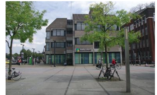
ABN-AMRO gebouw uit de jaren '80 (2011)
