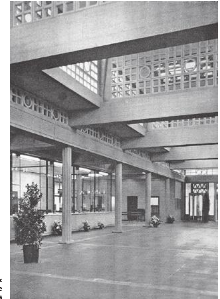
De pilaren staan oorspronkelijk vrij waardoor de basilicatypesologie beter zichtbaar is
