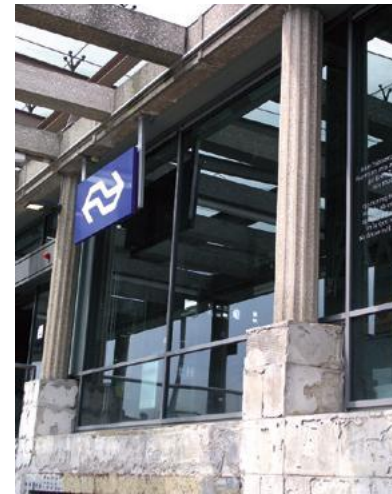
In plaats van op een borstwering te staan, hebben de kolommen nu sokkels gekregen
