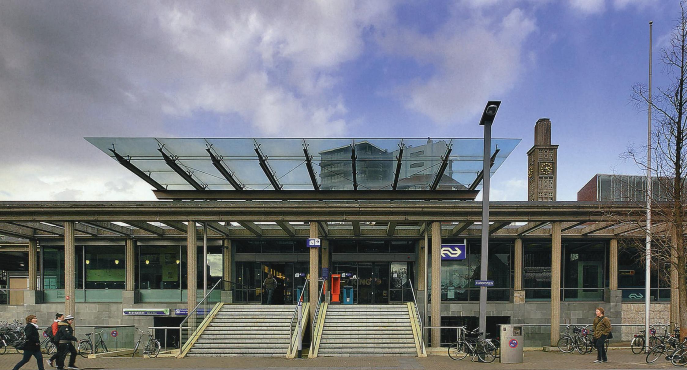
Nieuwe entree in Zuidgevel
