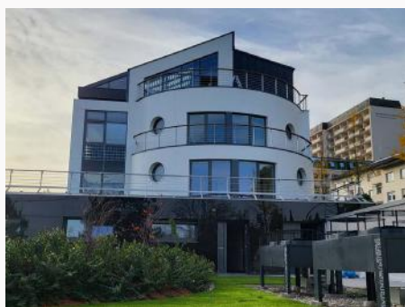
Luxuriöser Wohn- und Bürokomplex mit ca. 3.000 m 2 Nutzfläche, ca. 170 kW Erzeugungsleistung an Fassade und Dach, innovativem Heizsystem und H 2 -Langzeitspeicher. Bildquelle: ADITES GmbH
