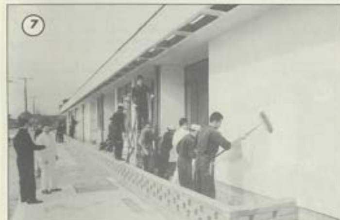
7. El 1º de Septiembre recién pasado, personal de Oficiales y Gente de Mar del DLH "Blanco Encalada" realizó un operativo de ayuda en el Hospital "Las Higueras" de Talcahuano. En la foto efectivos del buque realizando reparaciones en el frontis del establecimiento hospitalario.
