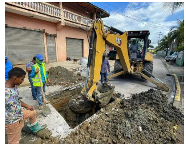
Reparación de algunas zonas en la isla de Roatán.
