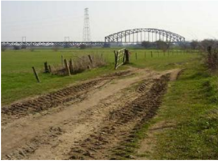
De spoorbrug bij Oosterbeek over de Nederrijn.
