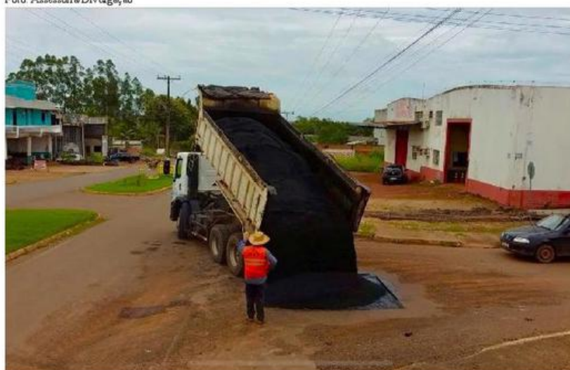
Os municípios que receberam a manutenção asfáltica são Novo Horizonte, Nova Brasilândia e São Miguel do Guaporé
