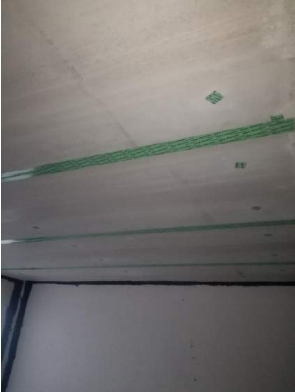
Ilustración 8 Prelosas pretensadas PRZ vna con juntas selladas mediante cinta específica Siga Rissan 100
