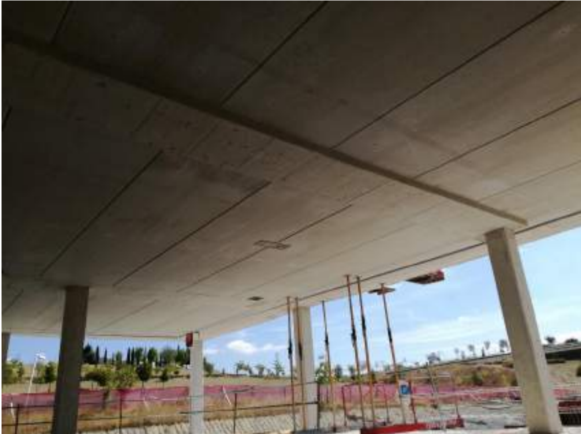
Ilustración 2 Prelosas instaladas con juntas vistas
