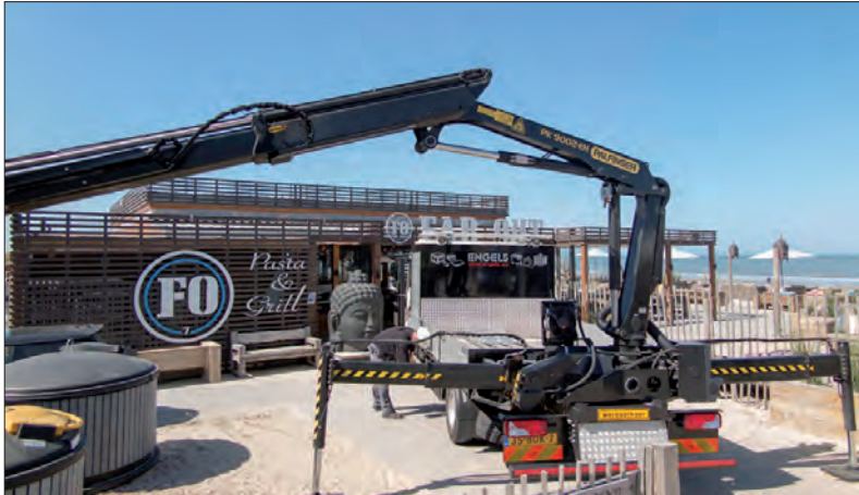
Onderhoudswerkzaamheden in Zandvoort.
