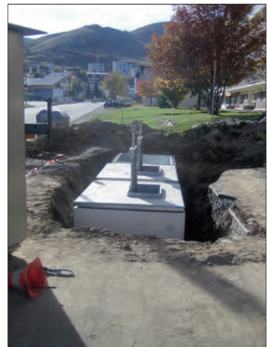
Een lokale aannemer kan de containers plaatsen.
