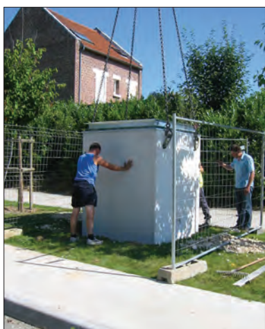
De betonput wordt in de voorbereide bouwput geplaatst.
