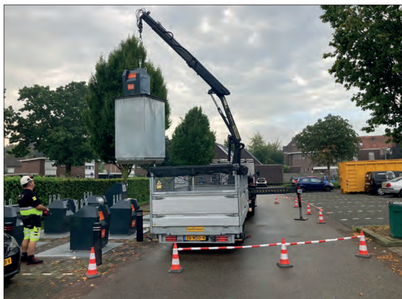
Locatie veilig gesteld. Werkzaamheden kunnen beginnen!
