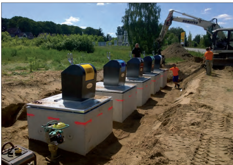
Containerparkje tijdens plaatsing in Selmsdorf, Duitsland.
