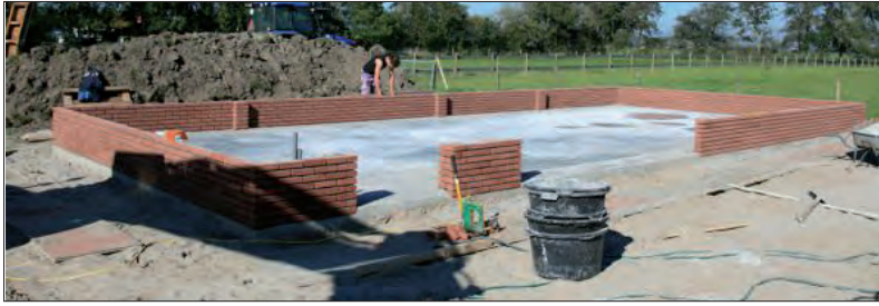
Mortelkuipen; sterk en weerbestendig. Ideaal voor in de bouw.
