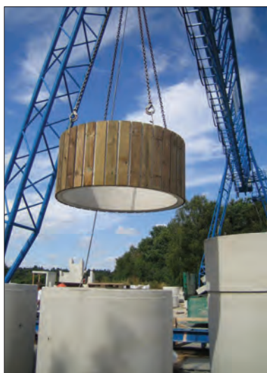
In de betonfabriek worden de beide gedeeltes van de silo al samengevoegd.
