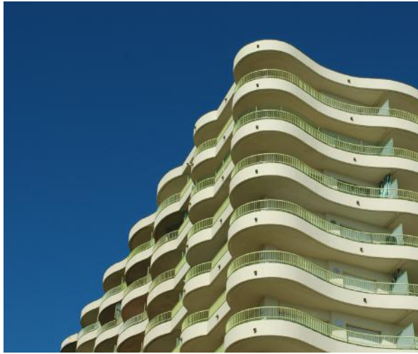
OBRA: Rehabilitació Façana SuperBeach SITUACIÓ: Miriamar, 27 - Platja d'Aro ANY: 2020
