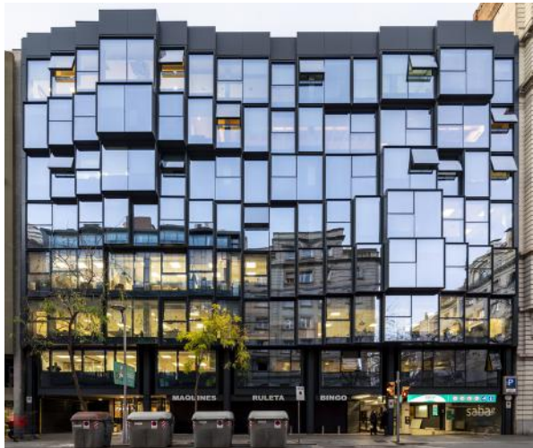
OBRA: Rehabilitació façana d'un edifici d'oficines SITUACIÓ: Travessera de Gràcia 17 - Barcelona ANY: 2021
