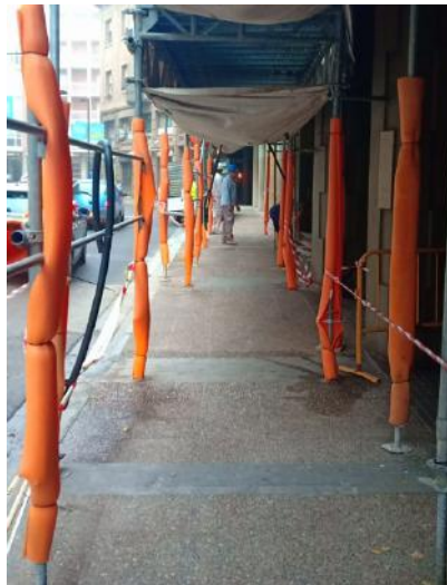
Pont de pas protecció vianants
