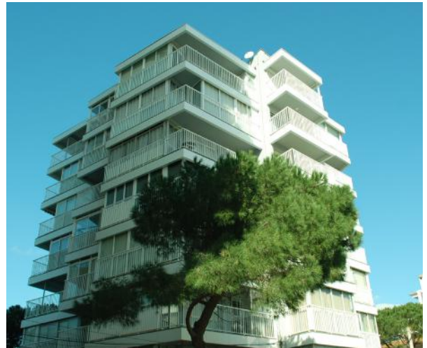
OBRA: Rehabilitació façana de l'edifici TURISMAR SITUACIÓ: Sant Sebastià, 24 - Platja d'Aro ANY: 2021
