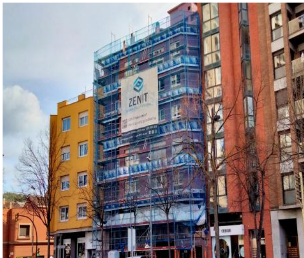
OBRA: Rehabilitació façana d'un edifici plurifamiliar SITUACIÓ: Ultonia 3 - Girona ANY: 2021
