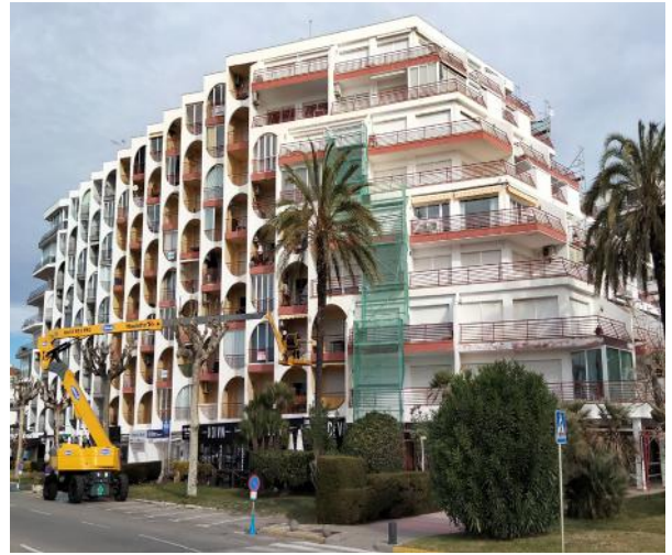
OBRA: Rehabilitació façana de l'edifici BAHIA II SITUACIÓ: Empuriabrava - Girona ANY: 2022
