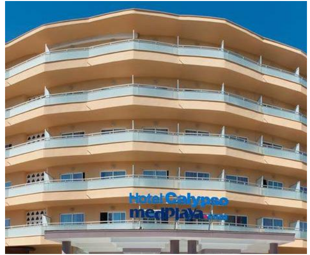
OBRA: Rehabilitació façana Hotel Calypso SITUACIÓ: Pompeu Fabra, 54 - Salou ANY: 2018
