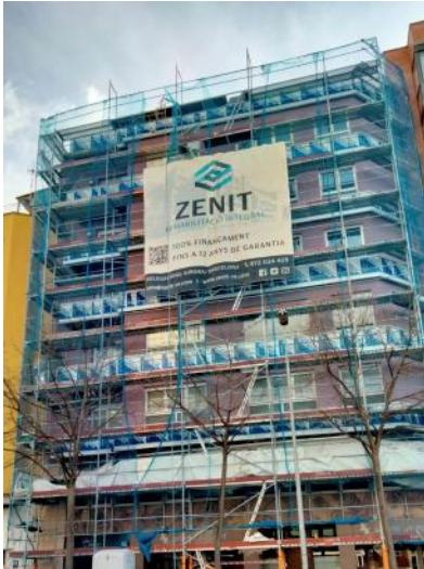
Bastida tubular metàl·lica
