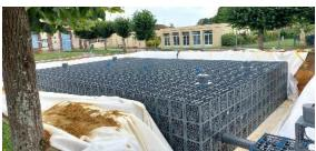
Après un décaissement sur 5 mètres de profondeur, la structure en casier a été placée. Le tout a été recouvert d'une bâche et recouvert de cailloux.
