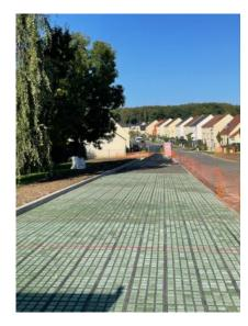
Le parking Rue Fossier est en o u r s d'aménagem ent: pose de bordure et mise en place de pavé drainant avec une couleur différente pour délimiter les places de parking.
