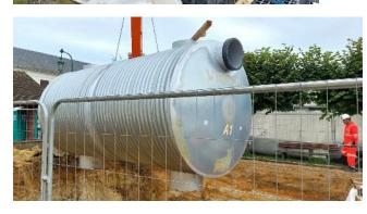
Une grande cuve a été placée en amont de la structure en casier. Elle permettra un préfiltrage.
