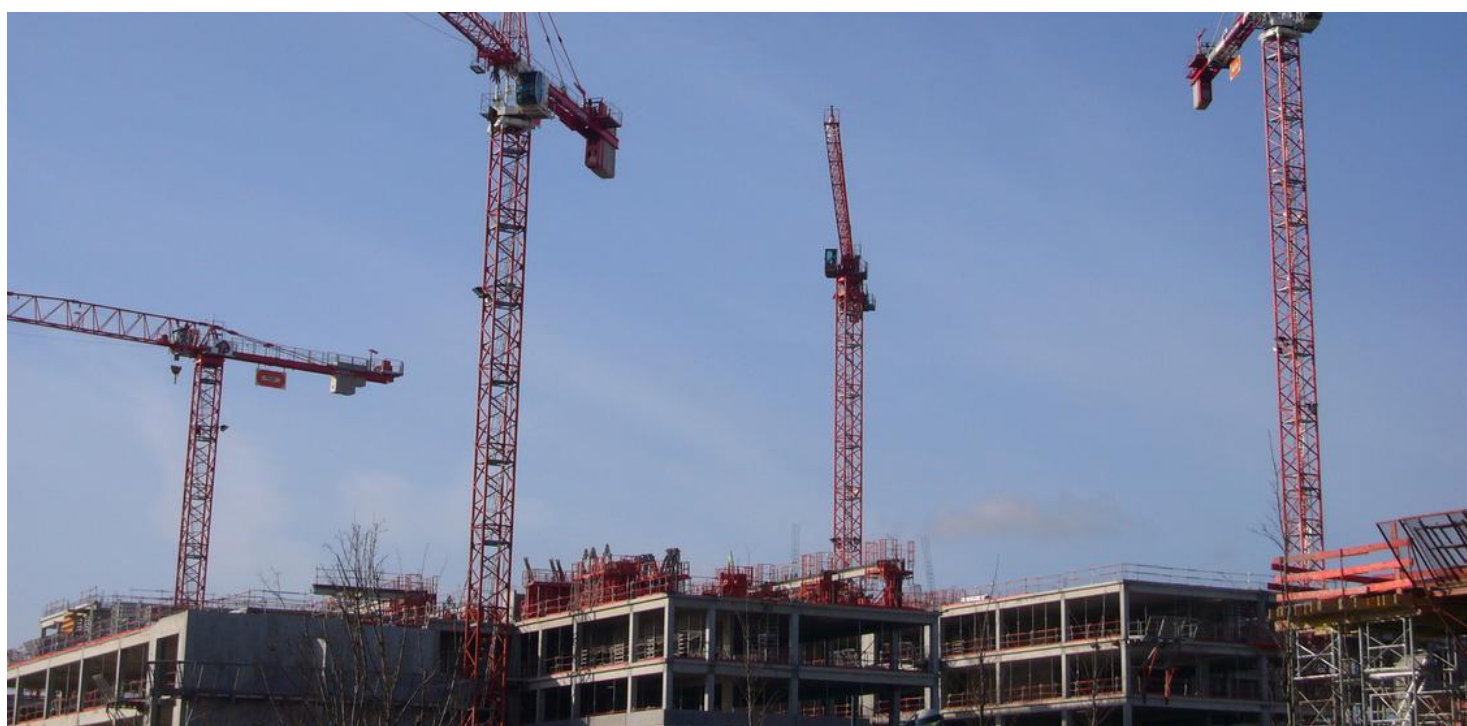
Constructions à Gennevilliers
