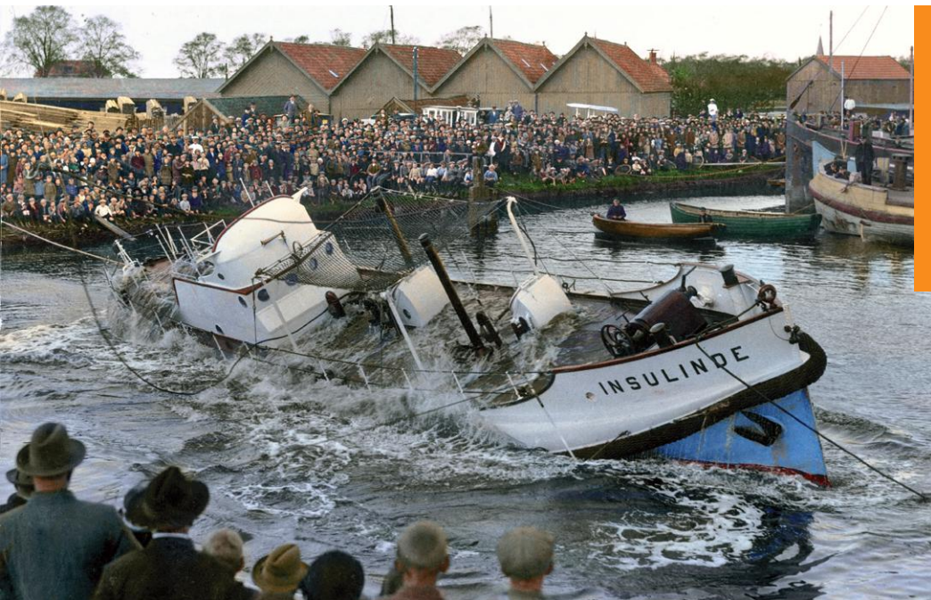
In 1927 werd de Insulinde te water gelaten. Dit was de eerste zelfrichtende stalen motorreddingboot ter wereld.
