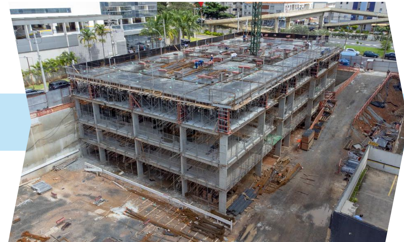
25 fev 2023 - 3º andar em andamento
