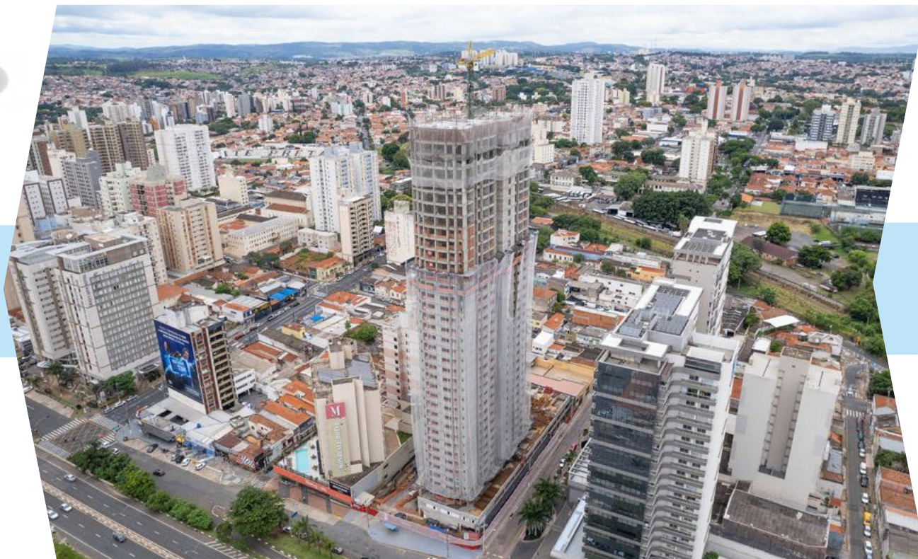
04 jan 2024 - 37º andar concluído
