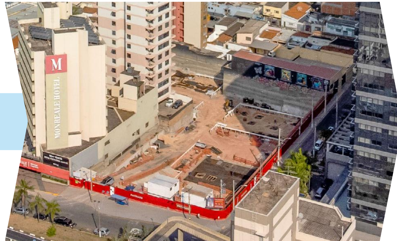
09 set 2022 - preparando as fundações
