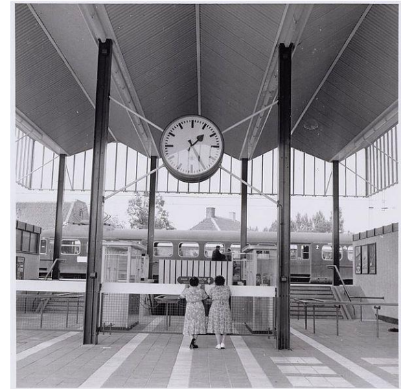
Centrale hal van station Sloterdijk Zuid, ontwerp Koen van der Gaast. [SAA]
