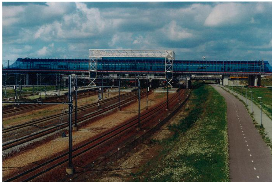
Oostzijde van het station voor de uitbreiding. De oostgevel werkte als een groot venster met zicht op de spoorbundel en Amsterdam. [Archief Spoorbouwmeester / Teo Krijgsman fotograaf]
