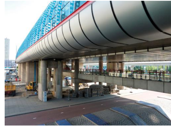
Betonnen constructie van de bovenperrons. De constructie is aan de onderkant afgedekt met aluminium panelen. Aan de bovenzijde is de tube afgedekt met raatliggers en glas.
