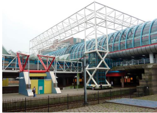
Poten van de tafelconstructie aan de oostzijde. In de poten zitten de liften die het maaiveld met de stationshal verbinden.
