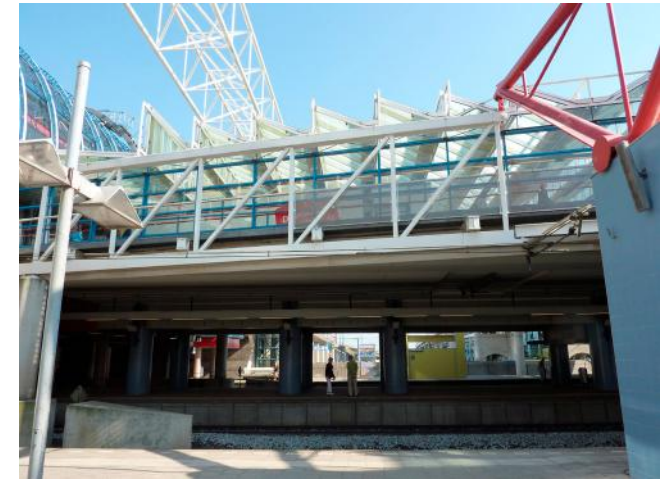
3. Uitbreiding van het station met een metroterminal (GVB). De uitbreiding heeft een trapeziumvormig plattegrond, de draagconstructie staat in lijn met het treinstation, maar is uitgevoerd in staal.
