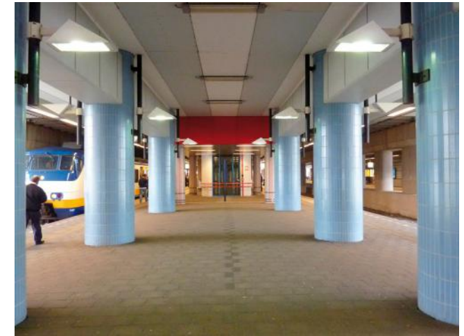
Betonnen kolommen op het middelste onderperron. Dit zijn de enige kolommen van de uitbreiding op de perrons.
