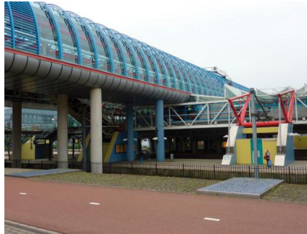
De constructie van de uitbreiding is als een brug vormgegeven. De vakwerkconstructie aan de zijkanten hangt aan een hijsconstructie van staal met betonnen poten (de oude liften van vóór 1983). In het midden steunt de uitbreiding op betonnen kolommen.
