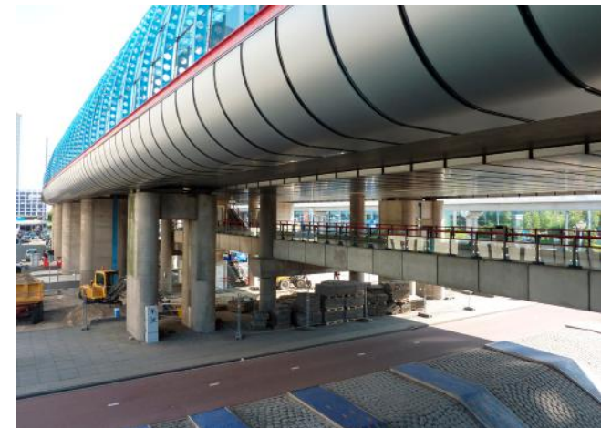
Net als het viaduct zijn de 'tubes' bekleed. Aan de onderzijde werden aluminium platen aangebracht, boven is gewerkt met gelaagd veiligheidsglas tussen de stalen raatliggers.
