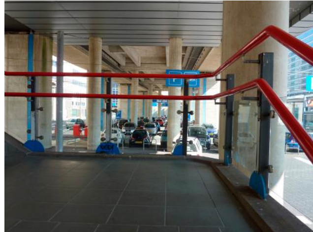
De trapleuningen zijn verbijzonderd bij de aansluitingen op de vloer.
