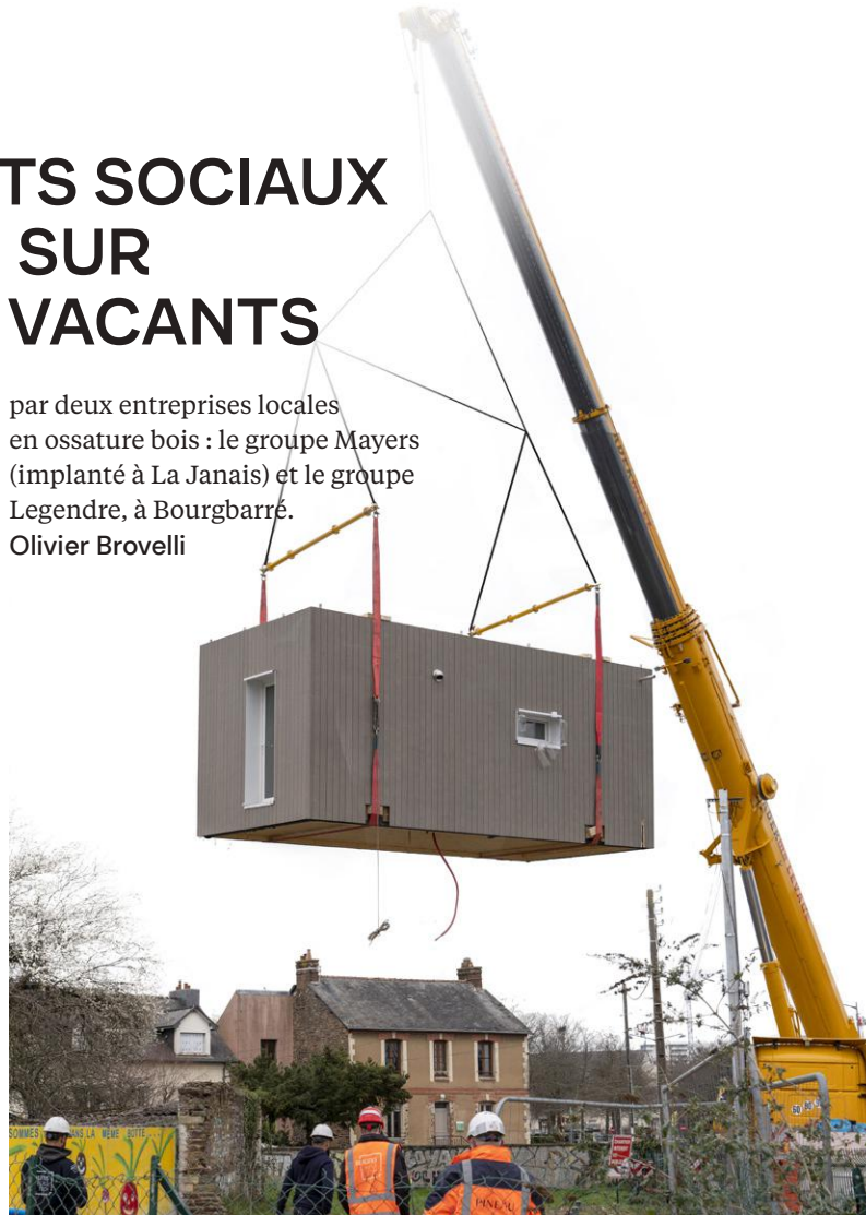
↑ Pose des premiers modules de logement près du cimetière de l'Est, à Rennes, en mai. D'autres viendront à Bruz, Saint-Jacques et Chevaigné.
