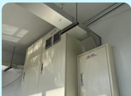
114學年度教室環境電源改善工程，更新明禮樓及勤思樓配電總盤。
