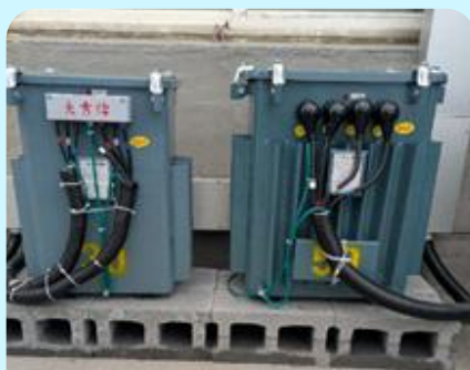
114學年度教室環境電源改善工程，更新明禮樓及勤思樓變壓器。
