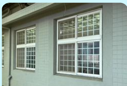
114學年度明禮樓教室外側牆面防水漆工程，避免牆面滲水及壁癌相關問題。
