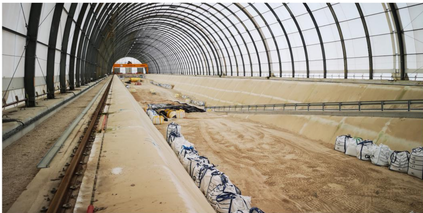
Vue d'une alvéole de stockage du Cires en cours d'exploitation
