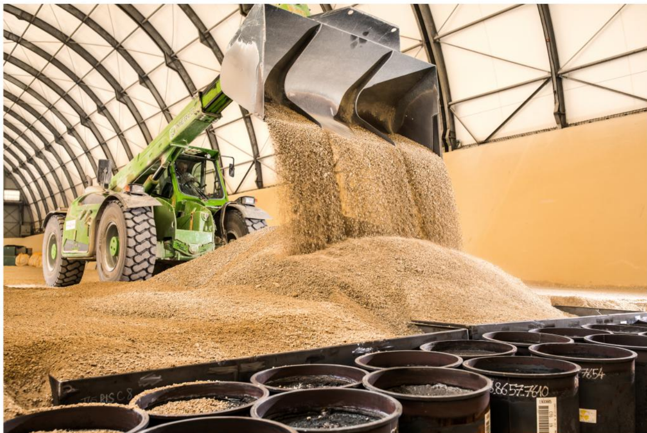
Gravillonnage de colis métalliques dans une alvéole du Cires (Photo : Andra / Adrien Daste)
