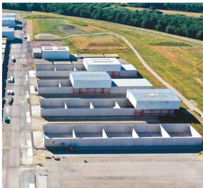
Ouvrages du CSA en cours d'exploitation (©Andra)
