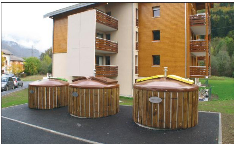
Tièrso-Systeme bei einem Spezialpflegeheim in Thônes (Frankreich).
