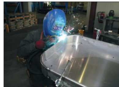
Schweißen der Bodenabdeckung.
