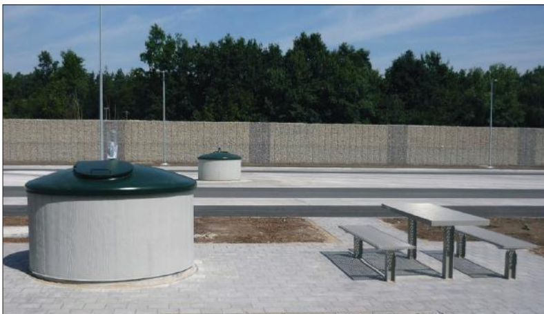
An der A6 in Deutschland. Der Architekt hat sich bewusst für Beton ohne Verkleidung entschieden.
