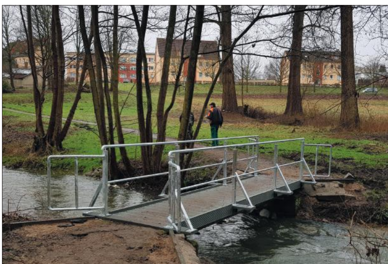
Zäune und Brückengeländer.
