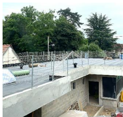
Étanchéité du toit terrasse
