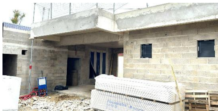
L'entrée principale attend ses menuiseries et sa grande porte d'entrée.
