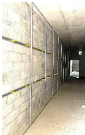
L'électricien, le plombier, le plaquiste, le peintre, le carreleur vont se succéder jusqu'à l'automne.
