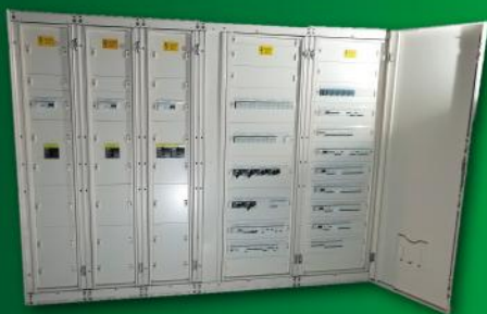
Főelosztó szekrény (CBA Prima élelmiszer áruház) Skybox (2400x2000x400mm)
