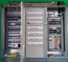
Főelosztó szekrény (CBA Prima élelmiszer áruház) Skybox (2400x2000x400mm)
