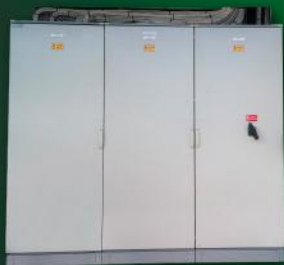
Főelosztó szekrény (CBA Prima élelmiszer áruház) Skybox (2400x2000x400mm)
