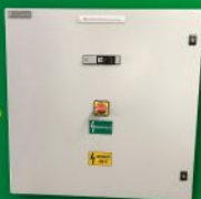
Hűtőtechnikai főelosztó és vezérlőszekrény (Penny Market, élelmiszer áruház) Schneider E. Spacial CRN (800x800x300mm)
