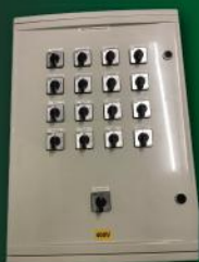
Hűtőtechnikai elosztó (500x700x245mm)
