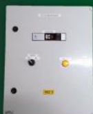
Hűtőkamra vezérlő (Wurm CRD-XP) (400x500x175mm)
