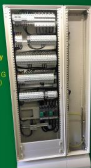
Főelosztó szekrény (Forgácsoló üzem) Schneider E. Prisma G (600x1900x250mm)
