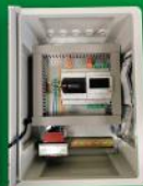
Expanziósszelep vezérlő (Carel EVD) (300x400x165mm)
