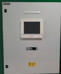
Hűtőtechnikai főelosztó és vezérlőszekrény (SPAR élelmiszer áruház) Schneider E. Spacial CRN (1000x800x300mm)
