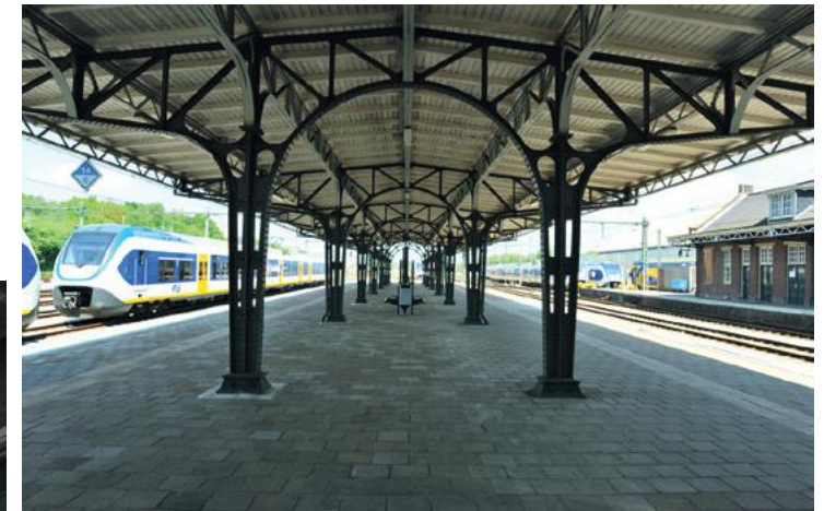
Noordelijke uiteinde van perron twee met uitzicht op het grootse emplacement. De overkapping zoneert het perron in de lengterichting in drieën. Het contrast tussen het donker geschilderde staal en het licht geschilderde houten dakbeschoot, doet de constructieve samenstelling goed uitkomen, 2013
