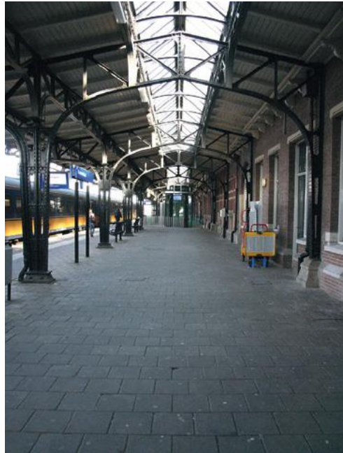
De lichtkappen van perron 1 ter plaatse van de dienstvleugel. Op de achtergrond de entree tot de voormalige bagagetunnel, nu tweede reizigerstunnel met liften, 2013
