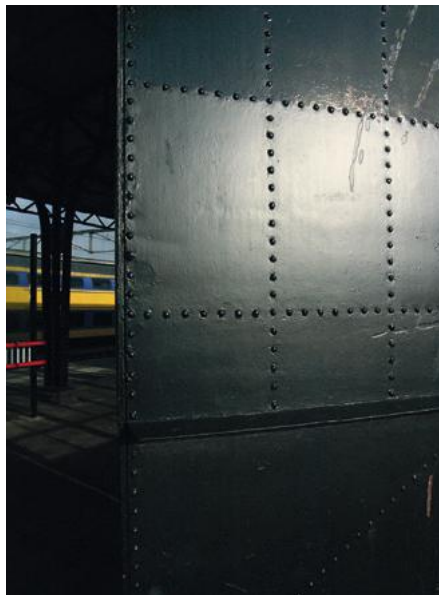
Detail van de fraaie stalen geklinknagelde deur in de perronwand, 2013
