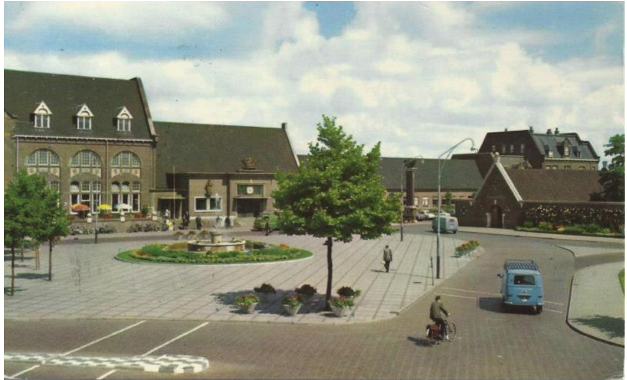
De zorgvuldige detaillering van de pleininrichting, diagonale bestrating, plantenbakken, fontein in het groen, verhoogd terras voor het station en een plantenstrook voor de siermuur, circa 1955 (col. DB)
