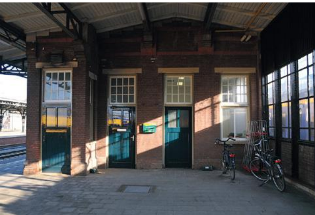
Zuidwestelijke gave kopgevel Gebouw Staf ter afsluiting van perron 1. Goed is te zien de integratie van gebouw, perronwand van glas en staal, en perronkap, 2013
