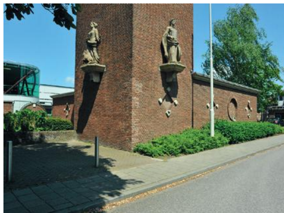
De toren van het ketelhuis op de hoek van het Stationsplein en de voormalige losstraat, nu Spoorstraat. Langs het ketelhuis ligt een groenstrook. Zichtbaar zijn de sporen van de verwijderde siermuur, 2013.
