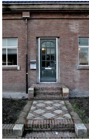
Van Ravestejn maakte de overgang in bouwperiodes zichtbaar. Overgang geblokt ornament van Van Heukelom in een ruitvormig ornament van Van Ravestejn, in de gevel van perrongebouw A (3). De verticale siersteen markeert de grens. 2013
