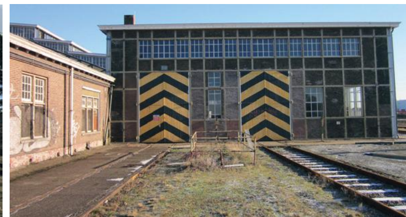
Front van de werkplaats, na de gevelrestauratie (2013)
