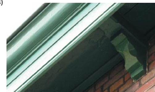
Details refereren aan de oorspronkelijke bouw uit 1907, zoals de houten gootlijst (2013)
