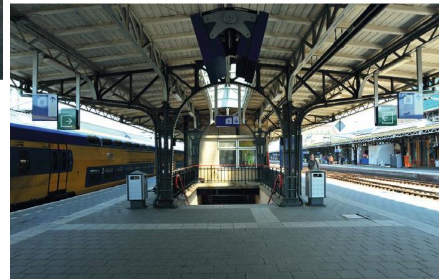
De reizigerstunnel wordt fraai belicht door de lichtkappen ter plaatse, 2013
