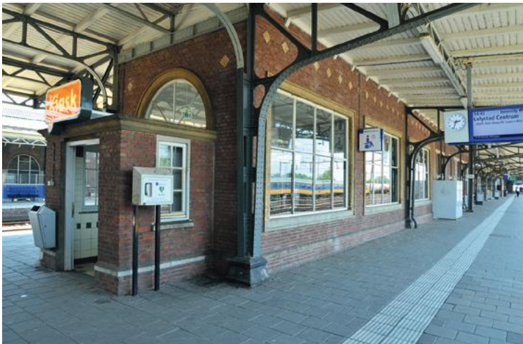
Gereconstrueerde entree van de voormalige wachttruimte aan de noordoostzijde, nu entree van de stationskiosk perron 2/3. Opvallend zijn de halfronde ramen in de kopgevel en de kloeke omrande glaspartijen. Het verbouwingsplan is toegeschreven aan Van Ravesteyn 1945-1949, foto 2013
