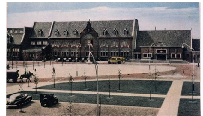
Stationsplein met parkeerterrein, plantsoen, verkeerscircuit en het herstelde station, circa 1950
