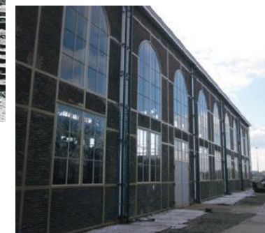
De langsgevel van de stallingsloods met de kenmerkende reeks boogvensters, na de restauratie (2013)
