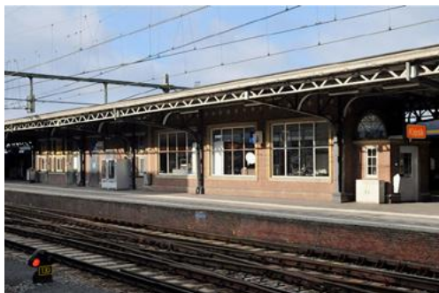
Eilandperron met perrongebouw A (3), 2013
