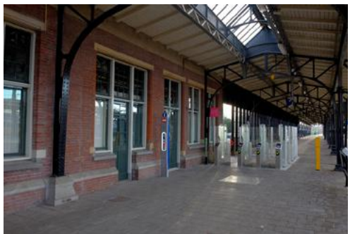
Ov-chippootjes ter plaatse van de zuidwestelijke uitgang van perron 1, december 2013
