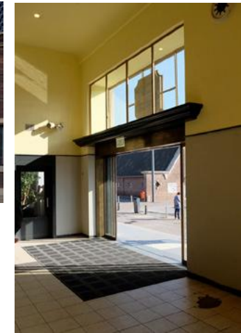
Stationshal, de entree deur met passende nieuwe glazen schuifdeur in bronzen profielen en de gereconstrueerde klok in het raam, okt. 2013
