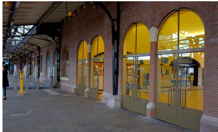
De nieuwe deuren en bovenlichten aan de perronzijde, dec. 2013
