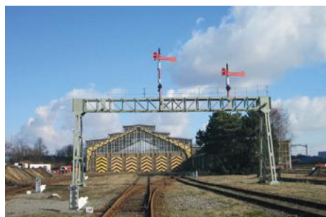
Verplaatste seinbrug en gerestaureerde locomotievenloods (foto 2013)
