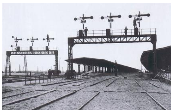
De karakteristieke seinbruggen met de seinarmen boven de sporen. Geen bovenleidingen vanwege het stoomtijdperk, 1907 (foto tijdens de bouw, 1907, Broos, p.91)
