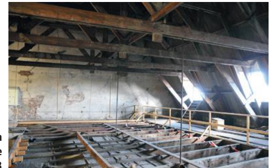
De lege zolderruimtes met dakkapellen, houten spanten en dichtgezette legramen van de bovenlichten van de voormalige wachtkamers, 2013
