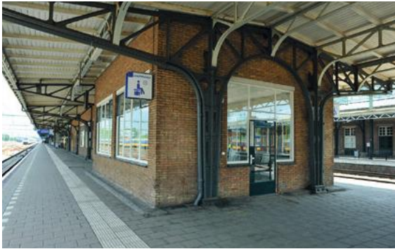
Entreezijde gezien vanuit het zuidwesten, gemetselde gevels met stalen ramen en deuren, 2013
