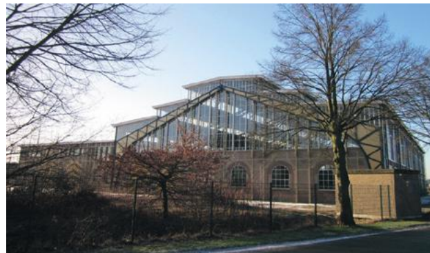
Gezicht op de noordoostgevel van de Locomotievenloods vanaf de Bosstraat (2013)
