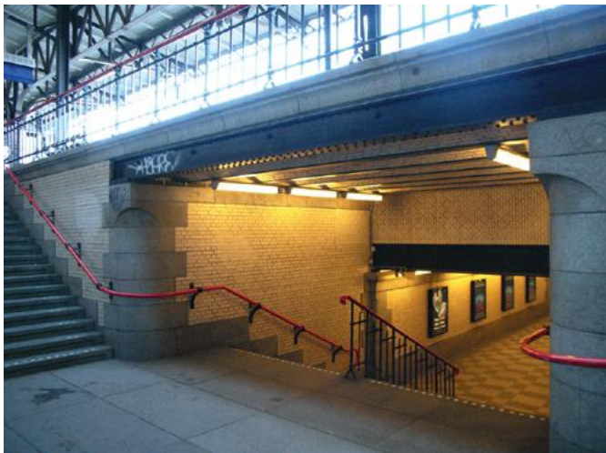
Zicht vanaf het tussenbordes naar perron en tunnel. Te zien is de strakke samengestelde constructie met ondermeer gewapend beton, natuursteen en metselwerk, 2013
