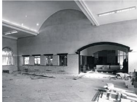
Afbouw van de door Van Ravestejn ontworpen entreehal, v.l.n.r. de ramen naar de perrons, de loketten en de bagage inname onder de boog, 1949 (col. HUA)
