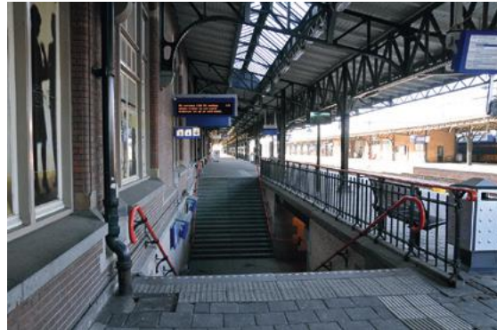
Lichtkappen ter plaatse van de personentunnel, 2013
