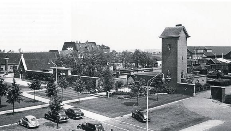
Luchtfoto van de pleinbebouwing gekeken in noordelijke richting, met v.l.n.r. pyloon, rijwielbewaarpplaats, siermuur met poort, plantsoen met teruggelegd priël en ketelhuis annex toren en doorgezette siermuur met een opening naar de achterliggende losweg, circa 1960. (col. HUA)
