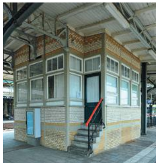
Voormalig perronseinhuis P (2) op het eilandperron, centraal gelegen tussen de trappen van de reizigerstunnel, Van Heukelom, 1907 (foto 2013)
