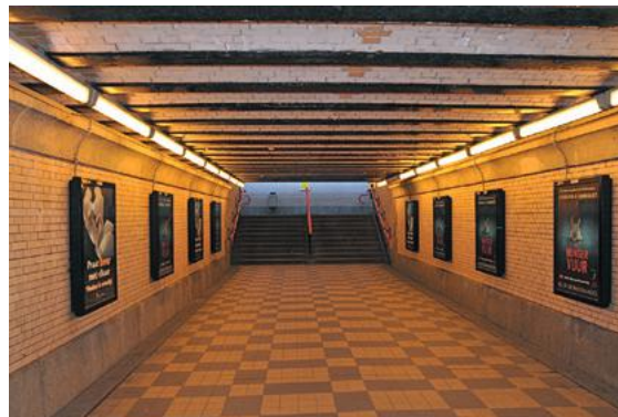
Zicht door de tunnel. Het plafond van de tunnel is gemaakt met profielbalken met daartussen bakstenen booggewelven, 2013
