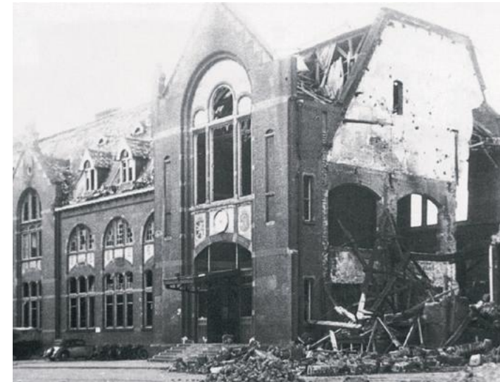
Het puin van het beschadigde middendeel van het stationsgebouw is begin 1946 verwijderd. De perronmuur is gedeeltelijk behouden gebleven. (Broos, 2004, p. 159)
