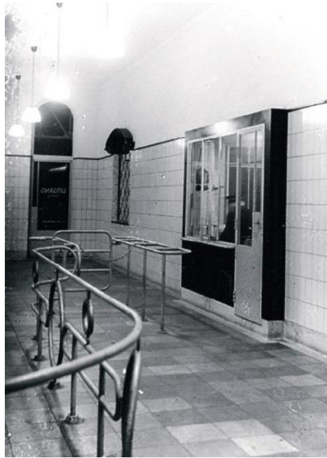
De gang tussen stationshal en het oude gedeelte met de wachtkamers, gekeken richting perron 1. Van Ravesteyn, 1950 (HUA, foto: L. Hessels, 1950)
