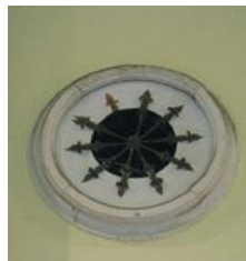
Origineel ornament op de voorgevelwand waarachter zich een luidspreker bevond, 2013
